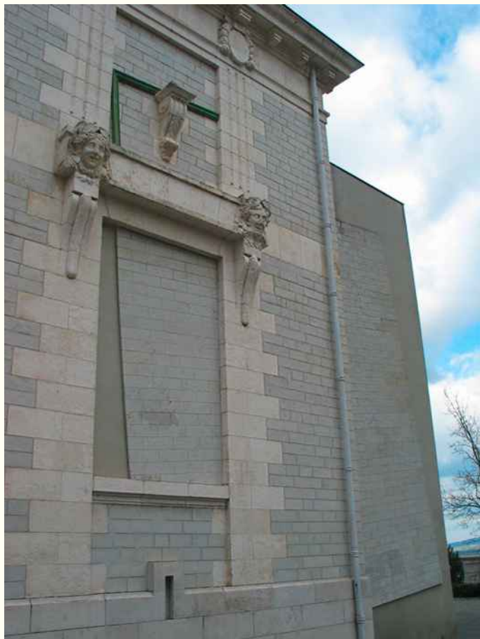
Cercle et carré (le carré), intégration architecturale, 1989, mur pignon sud du musée Denys-Puech, Rodez
