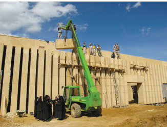
Levage et pose d'un bloc de pierre massive.
