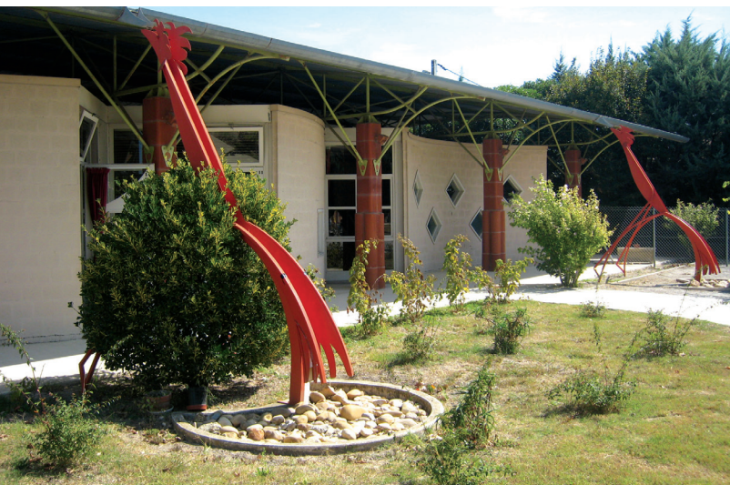
Les gargouilles-«gallines» évacuent les eaux de pluie jusqu'au «nid», qui contient des «œufs» en galets.
