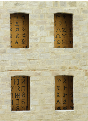
Les percements d'origine de la façade en pierre laissent apparaître la façade en verre et cuivre.
