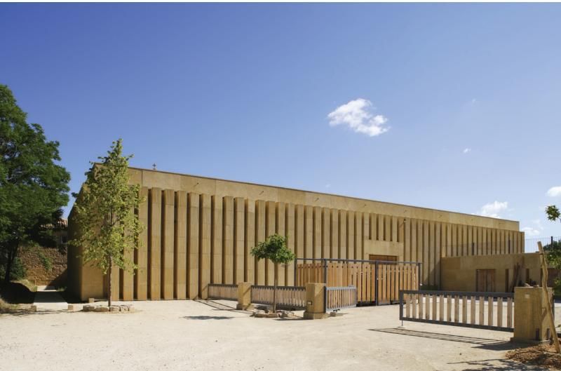
Vue d'ensemble de la façade côté parking.
