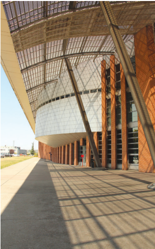
Façade, détail de l'amphithéâtre et auvent monumental.
