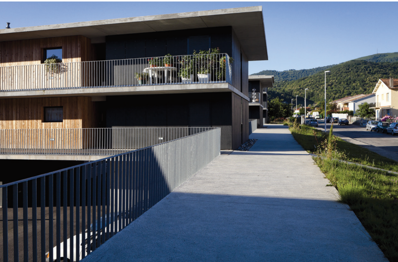
Accès aux bâtiments.
