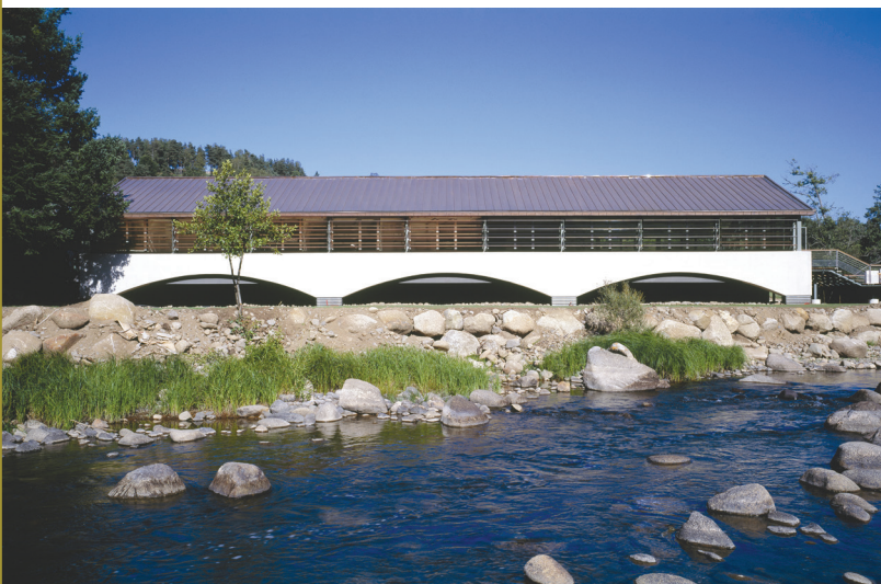
Bâtiment-pont au bord du Bès.
