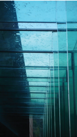
Détail de la toiture en verre de l'entrée.
