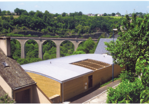
La toiture de la façade nord s'ajoute au dessus du patio.
