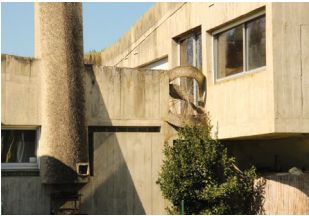
Détail du béton.
