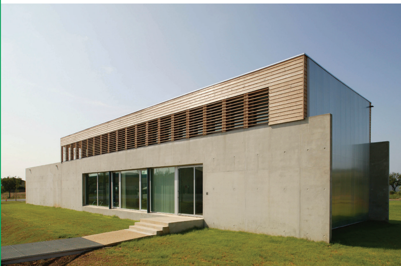
Façade est, côté pistes.
