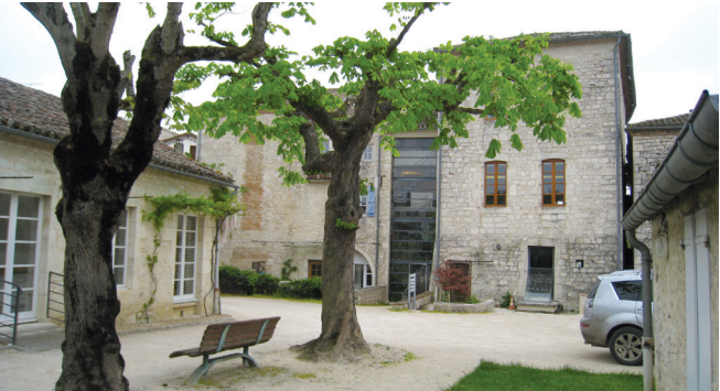
Façade arrière de la maison Jacob ouvrant sur le cœur d’îlot de la maison de retraite Saint-Luc.
