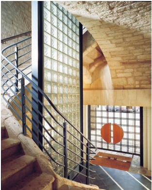
L’intervention sur l’escalier du hall, caractérisé par la sobriété du matériau et du dessin du garde corps met en valeur la structure ancienne du bâtiment.
