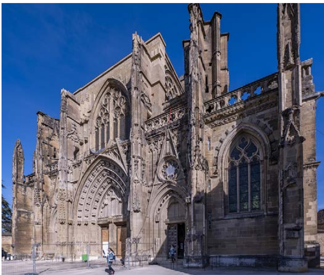
Abbaye de Saint-Antoine-l'Abbaye © Fondation du patrimoine_MyPhotoAgency-J.Penel
