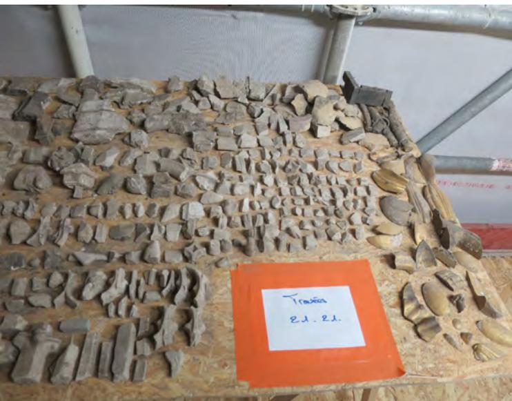
Fig. 18 : Vue des fragments retrouvés étalés en vue de rechercher leur place d'origine.
