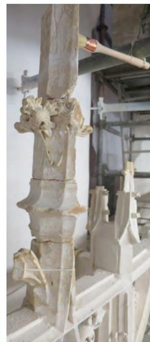
Fig. 21 : Vue du remontage d'un pinacle à partir de fragments retrouvés.
