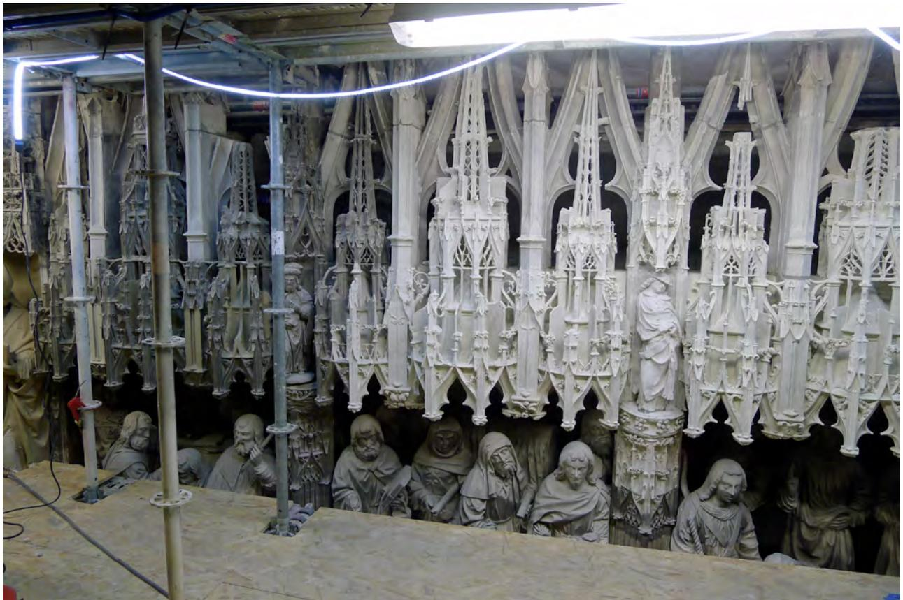
Fig. 29 : Les architectures en cours de nettoyage.
