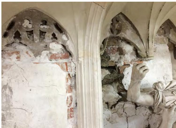
Fig. 4 : Vue de la façade arrière de la structure grossièrement bouchée en brique enduite à la fin du XVIII<sup>e</sup> siècle.
