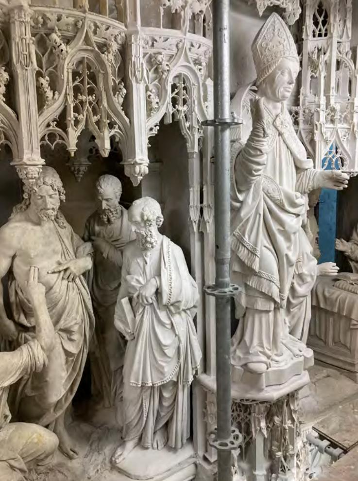
Fig. 33 : Vue de l'application en cours du badigeon sur une scène et des dais en tuffeau.
