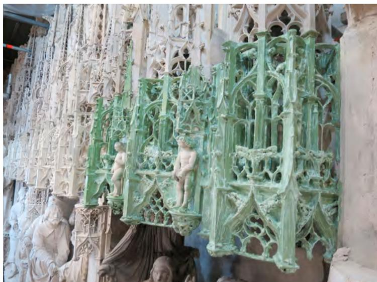
Fig. 11 : Vue de l'application de latex sur des éléments architecturés.
