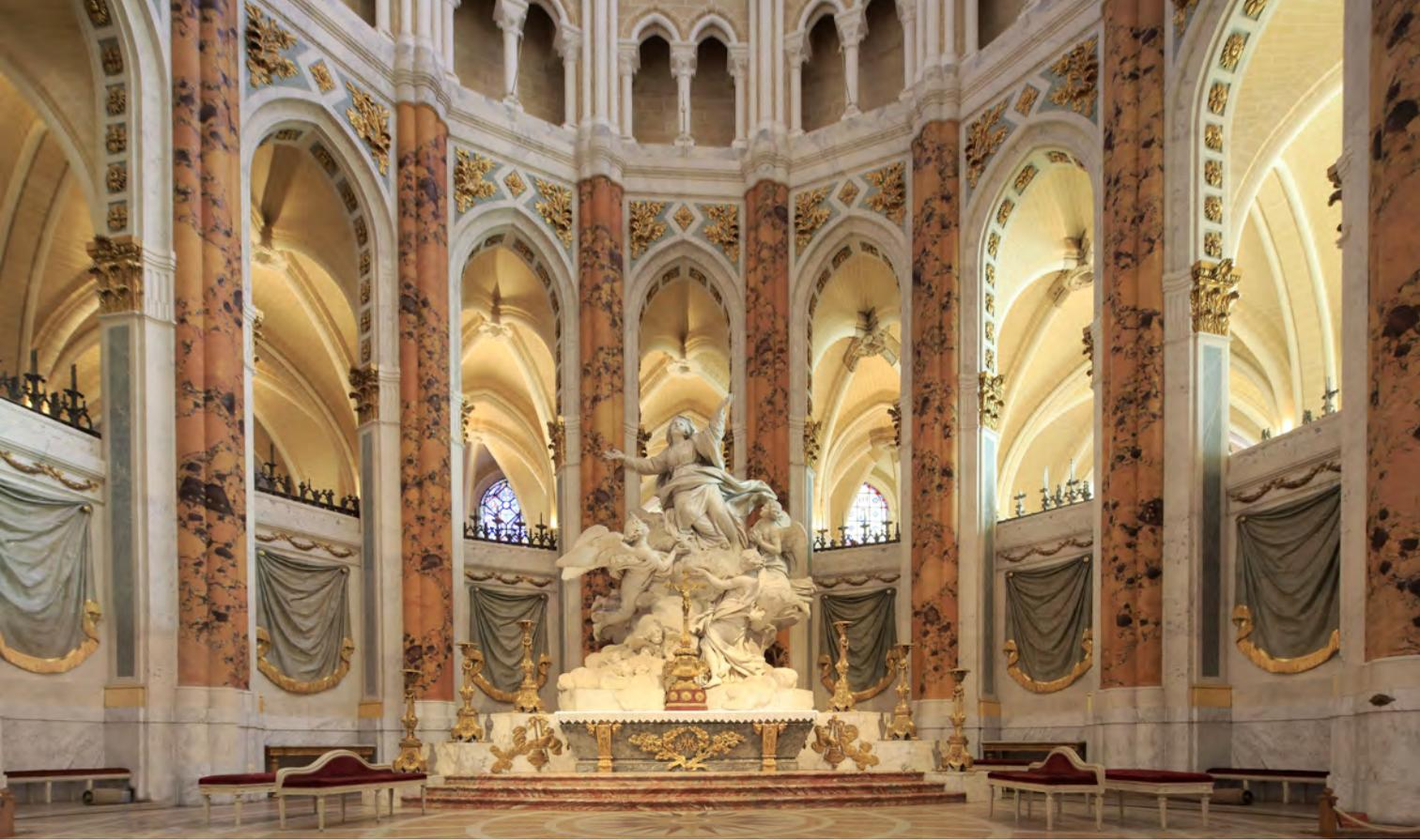
Fig. 52 : Vue du mur rapporté au XVIII<sup>e</sup> siècle à l'intérieur du chœur, avec de fausses draperies.
