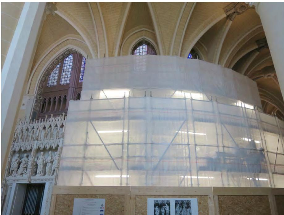
Fig. 24 : Vue des échafaudages encoffrés.
