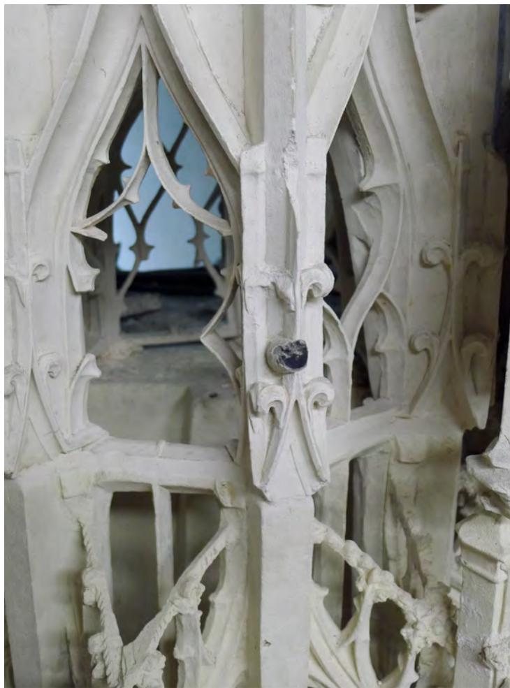
**Fig. 26** : Détail d'un dais dont la partie supérieure est en pierre de Vernon (avec un silex visible) et la partie inférieure en tuffeau.
