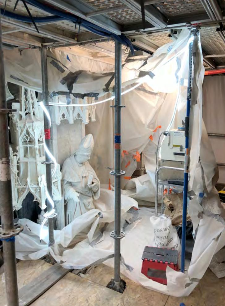
Fig. 28 : Installation des postes de micro-sablage.
