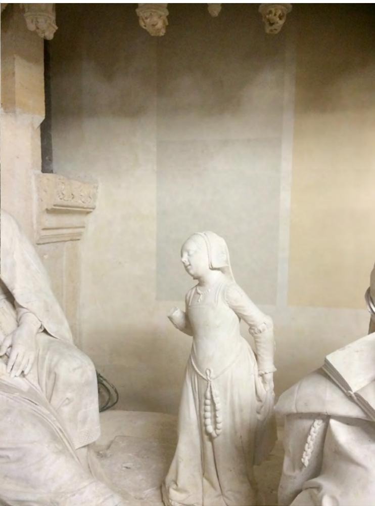
Fig. 17 : Vue d'essais de badigeon sur les enduits de fond.
