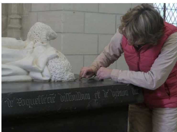
Id. Bouchage du joint sous le gisant.
