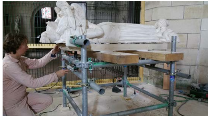
Id. Le gisant est séparé en douceur de la semelle de calcaire après extraction des fers.
