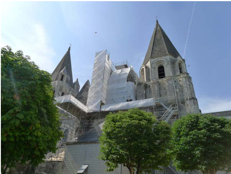
Loches, église Saint-Ours en cours de restauration en 2019.
