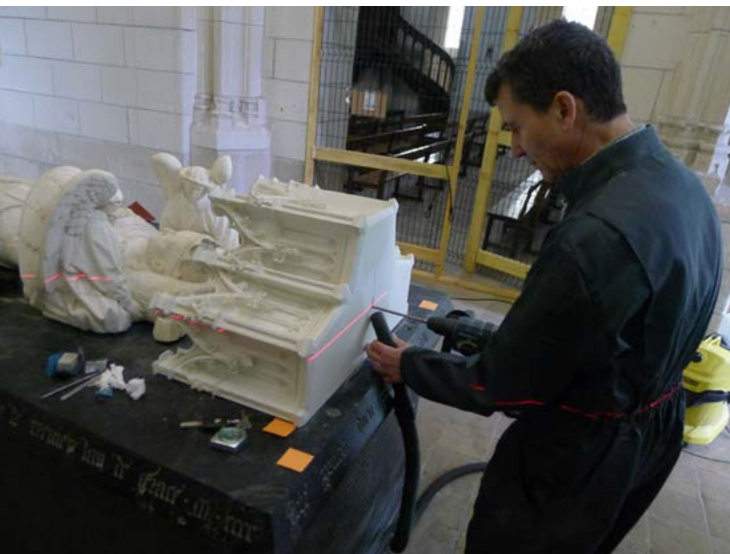
Id. Perçage dans le dais restitué du trou de fixation de la plaque gravée.
