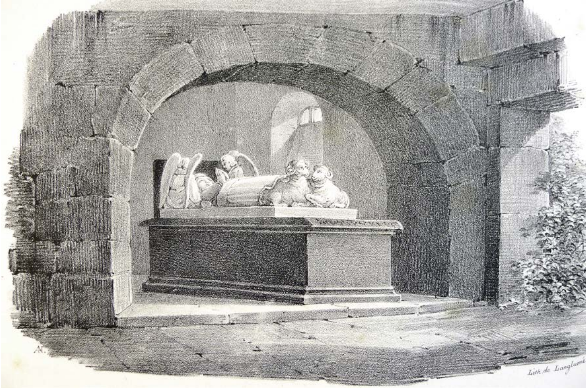
Loches, tour d'Agnès Sorel, vue intérieure du rez-de-chaussée, lithographie d'après un dessin d'A. Noël, 1824 (Noël 1824, pl. 50). L'arc donnant à voir le tombeau est factice. À noter la petitesse de la baie, qui ne devait dispenser qu'un très faible éclairage.
