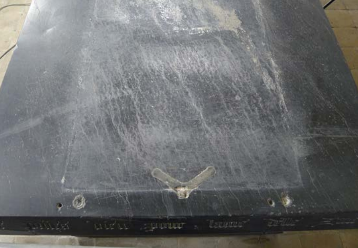
Restauration de 2015-2016. Dalle supérieure après dépose du gisant et de sa semelle de calcaire. Réapparition du logement en forme de V de la patte d'étaieement assurant la fixation de la plaque de marbre noir adossée au dais disparu.
