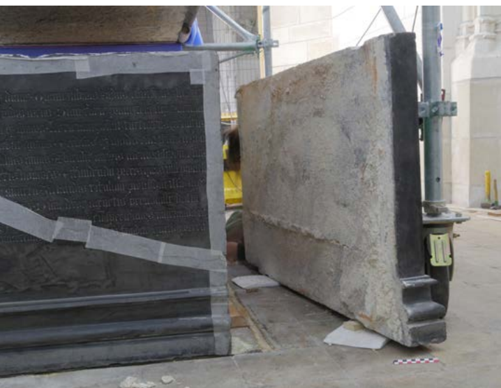
a, b : /d. Dépose et remise à leur place des petits côtés du coffre. La structure interne en briques creuses créée en 2005 réapparaît.
