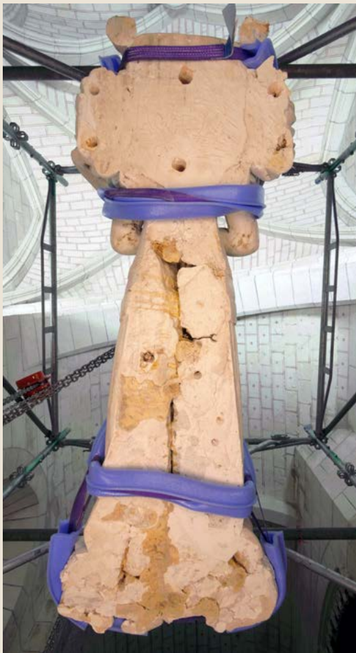
Vue de dessous du gisant, montrant les trous d'extraction des goujons en fer incorporés par Beauvallet.
