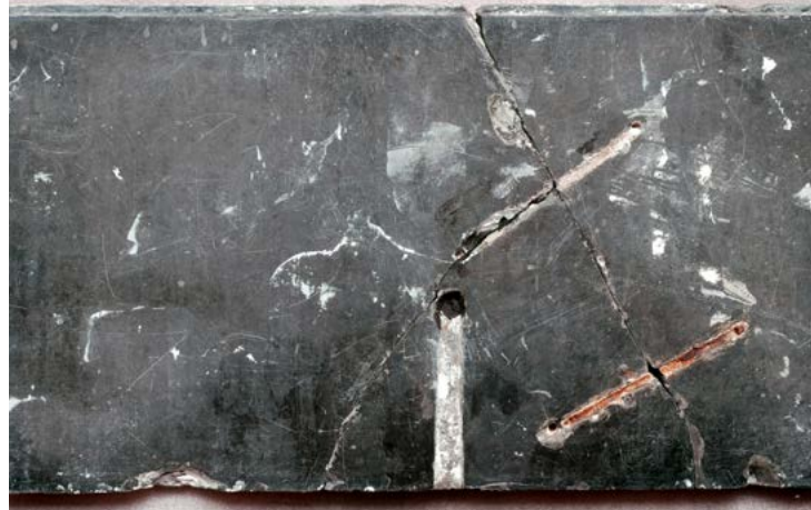
Id. Vue du revers. Traces de deux agrafes de réparation en fer. Au centre, trou de scellement et saignée de la fixation d'origine.
