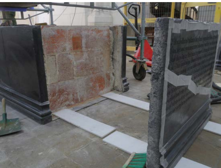
Restauration de 2015-2016. Dalle supérieure après dépose du gisant et de sa semelle de calcaire. Réapparition du logement en forme de V de la patte d'étaieement assurant la fixation de la plaque de marbre noir adossée au dais disparu.
