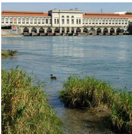
Centrale hydroélectrique de Cusset Villeurbanne, Rhône, Rhône-Alpes ©Patrice Dhumes
