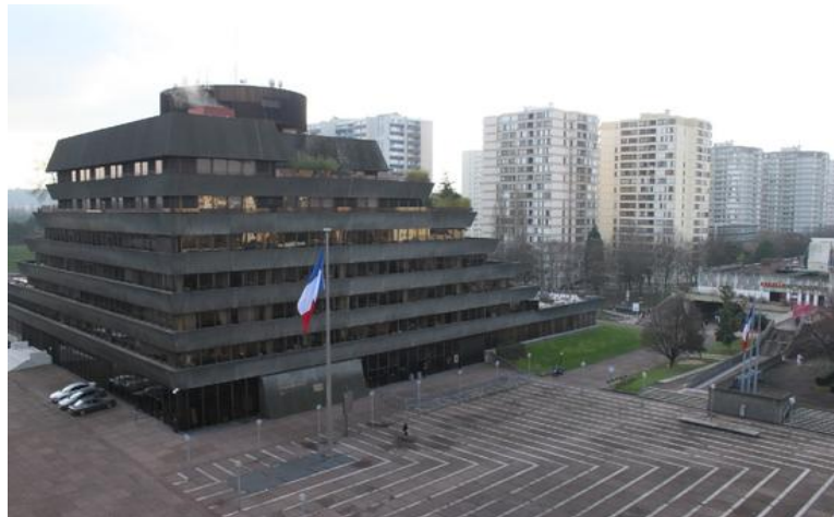
Préfecture de Seine-Saint-Denis à Bobigny
