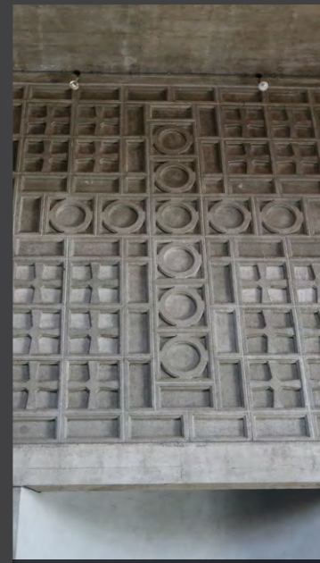
Détail d'une paroi de la nef © S. Marchant / DRAC CVdL.
