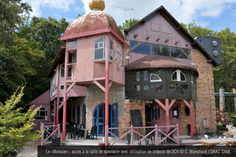
Le «Boissier», accès à la salle de spectacle avec utilisation de châssis de 2CV © C. Blanchard / DRAC CVdL.
