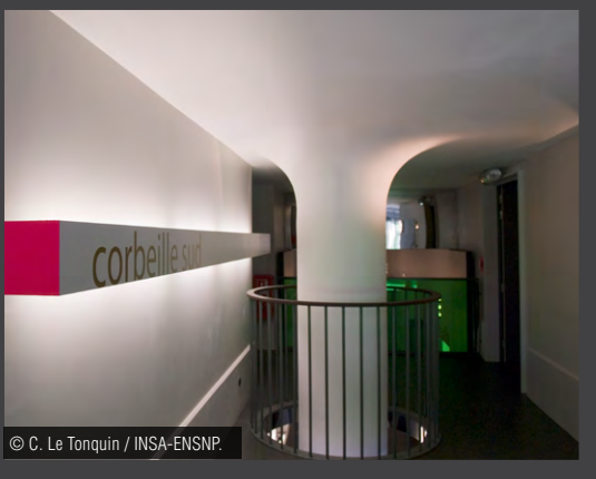
Colonne à évaseement de l'atelier nord © C. Le Tonquin / INSA-ENSNP.
