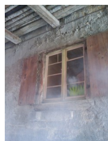
Quelques éléments dont le mauvais entretien est responsable de défauts d'étanchéité à l'air (source : Cerema)
