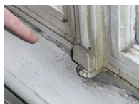
Quelques éléments dont le mauvais entretien est responsable de défauts d'étanchéité à l'air (source : Cerema)
