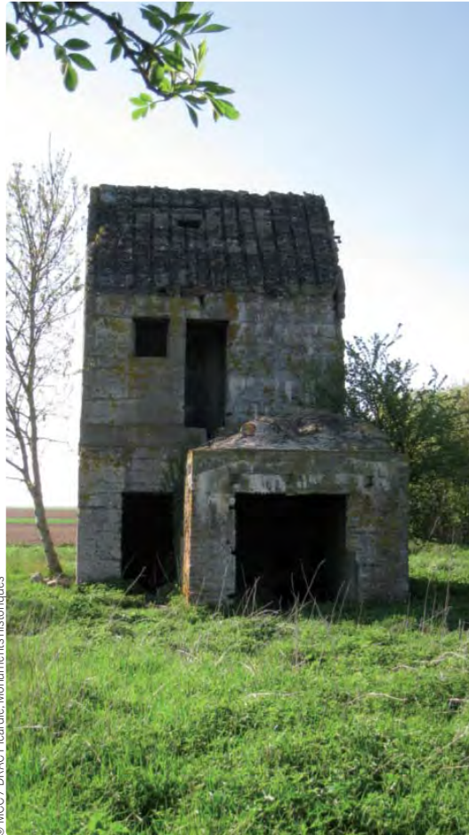
Blockhaus allemand camoufflé de La Chavatte (Somme), près de Roye, inscrit le 19 avril 2012. Ce blockhaus en béton armé fut bâti en 1915 par les Allemands, sous la forme d'une habitation rurale qui le camouflait.
