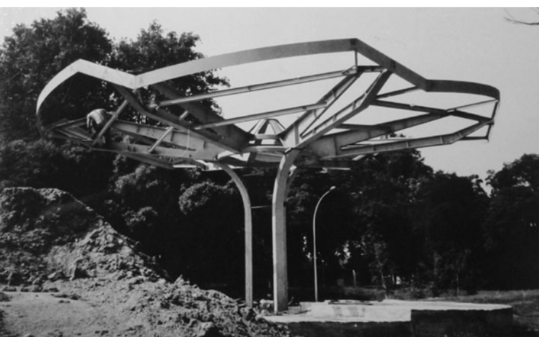
[Fig. 5] Le Kiosque-Corolle en cours de construction, 1974
