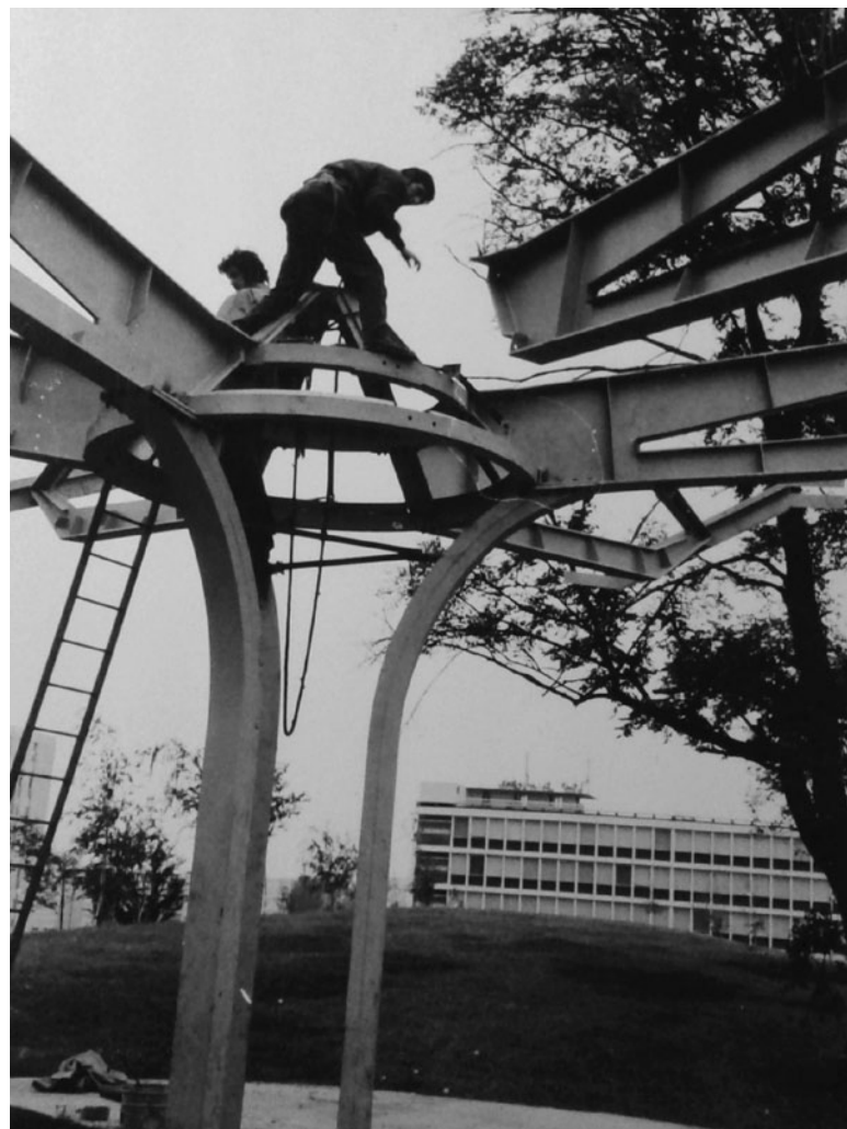
[Fig. 6] Le Kiosque-Corolle en cours de construction, 1974
