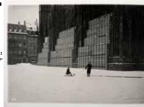
Protection du portail principal Fond privé - 1940
