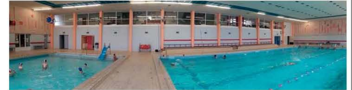
PHOTO HALLE BASSIN EXISTANTE
