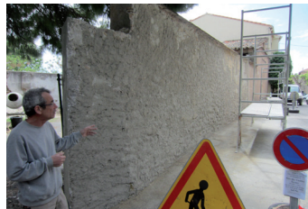
Plusieurs passes d'enduit ont été nécessaires afin de rendre le support le moins irrégulier possible en vue de l'application de la couche de finition.
