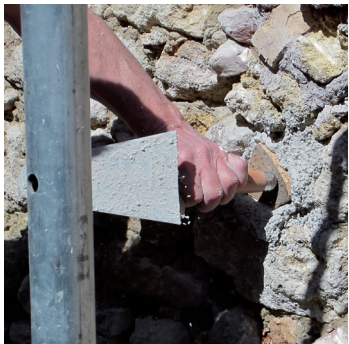
Ragréage aux tuileaux (issues de tuiles anciennes non silicoonnées).
