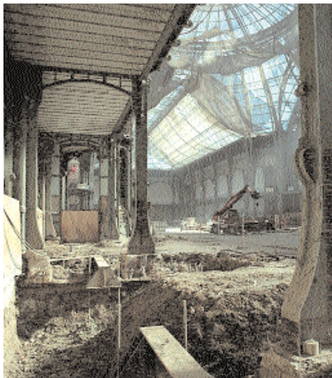
Vue de la nef du Grand Palais lors des travaux de rénovation © P. Coudert/EMOC/Paris, juillet 2002
