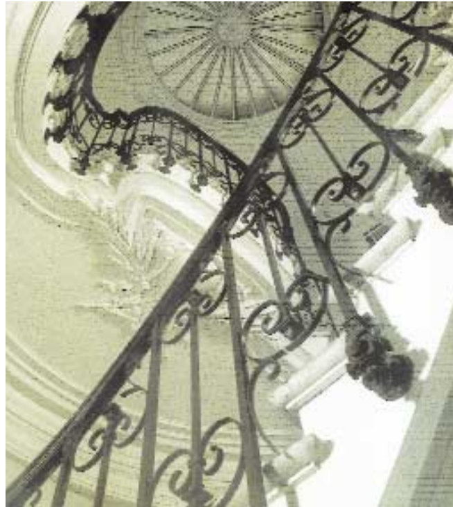
École nationale du patrimoine © Werner Jeker, Les ateliers du Nord, Lausanne
