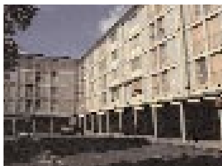
Drancy, Cité de la Muette (Arch. Beaudoin et Lods 1933-34) Aile de droite du bâtiment en U cl.Drac Ile-de-France/CRMH/C.Inizan
