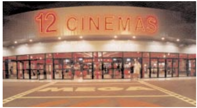
Entrée du multiplexe Méga CGR, à Rivesaltes, Perpignan, photo © CGR
