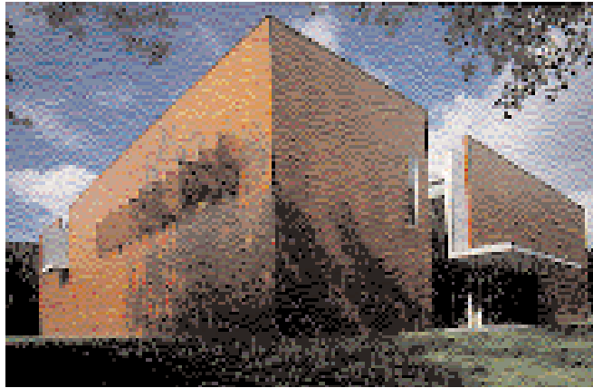
Frac des Pays de la Loire, Carquefou, photo S. Bellanger © Frac des Pays de la Loire
