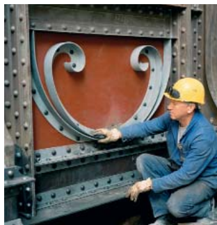
Chantier du Grand Palais, Paris © Patrick Tourneboeuf/EMOC/Tendance Floue.
