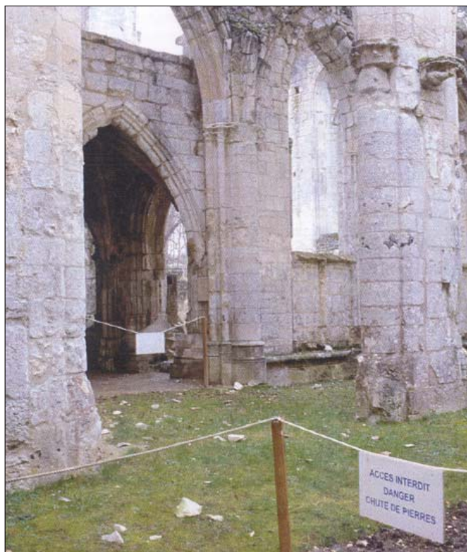
L'abbaye de Jumièges fait l'objet d'une restauration © D.R.
