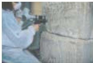
L'opération de restauration du pilier des Nautes © D.R.
