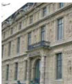
Façade de l'École du Louvre © D.R.
