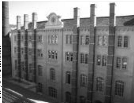
Facade nord du laboratoire du CICRP (vu de l'arrière du bâtiment).
