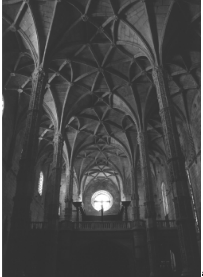
Eglise du Monastère des Jerónimos. Voûte des nefs. Première moitié du XVI e siècle
