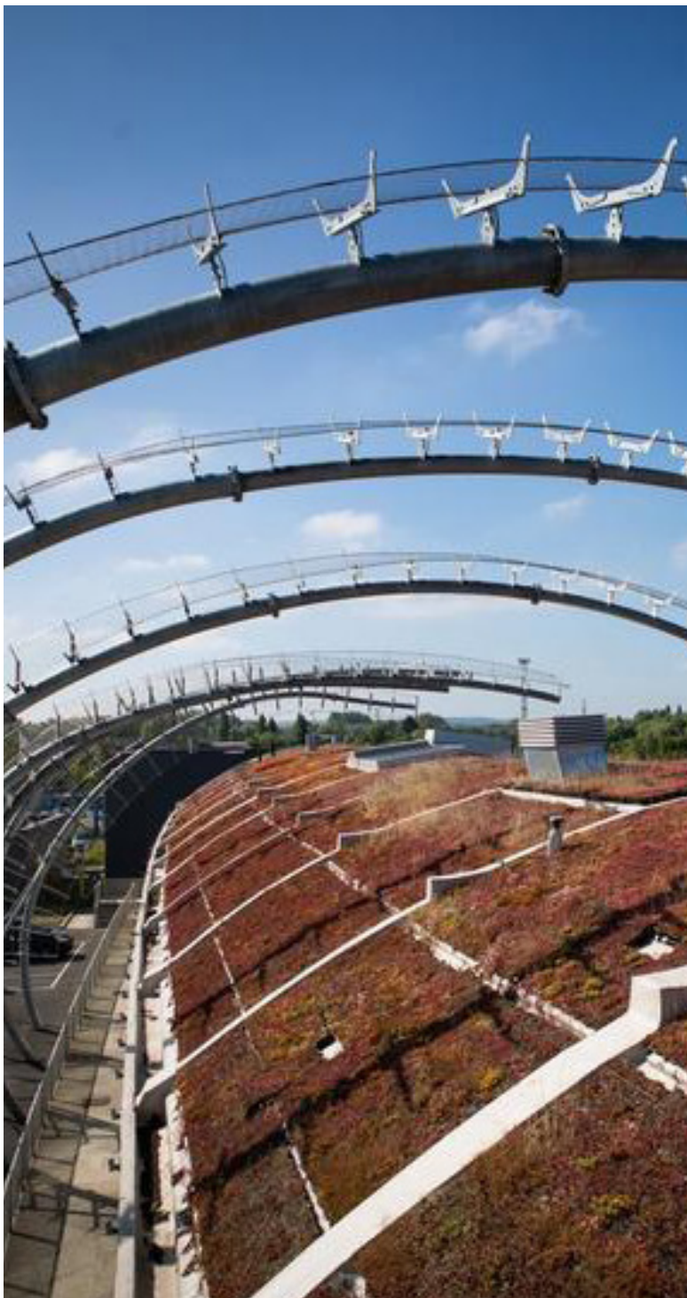
Le toit de l'immeuble Garopôle (Abbeville) © BS3V
