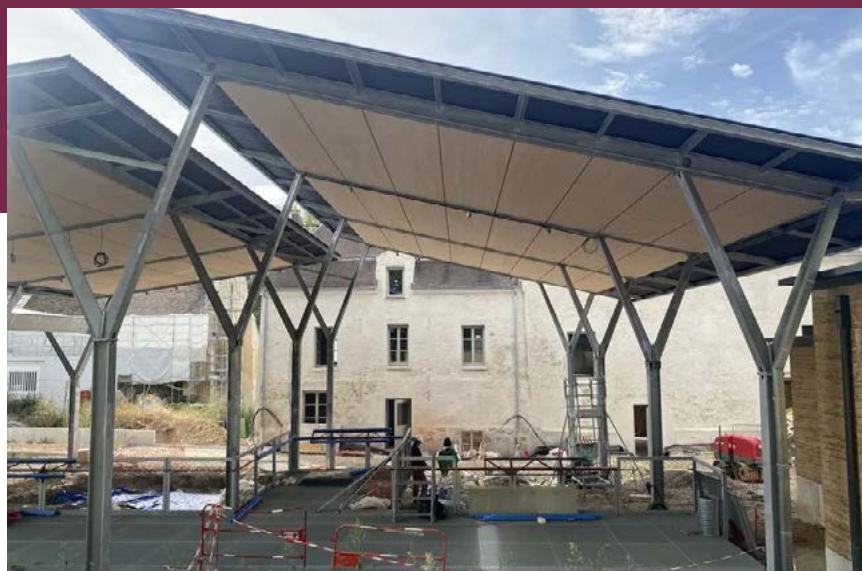
Chantier de l'archéo-site des potiers de l'Ysieux © Roissy Pays de France
