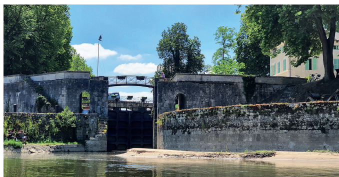
Écluse de Mantelot – Châtillon-sur-Loire (45)
