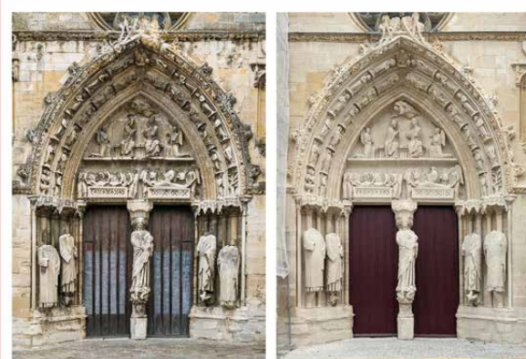
91 – Basilique Notre-Dame-de-Bonne-Garde de Longpont-sur-Orge portail avant-après restauration © Agence ABDPA – SARL Architecture
