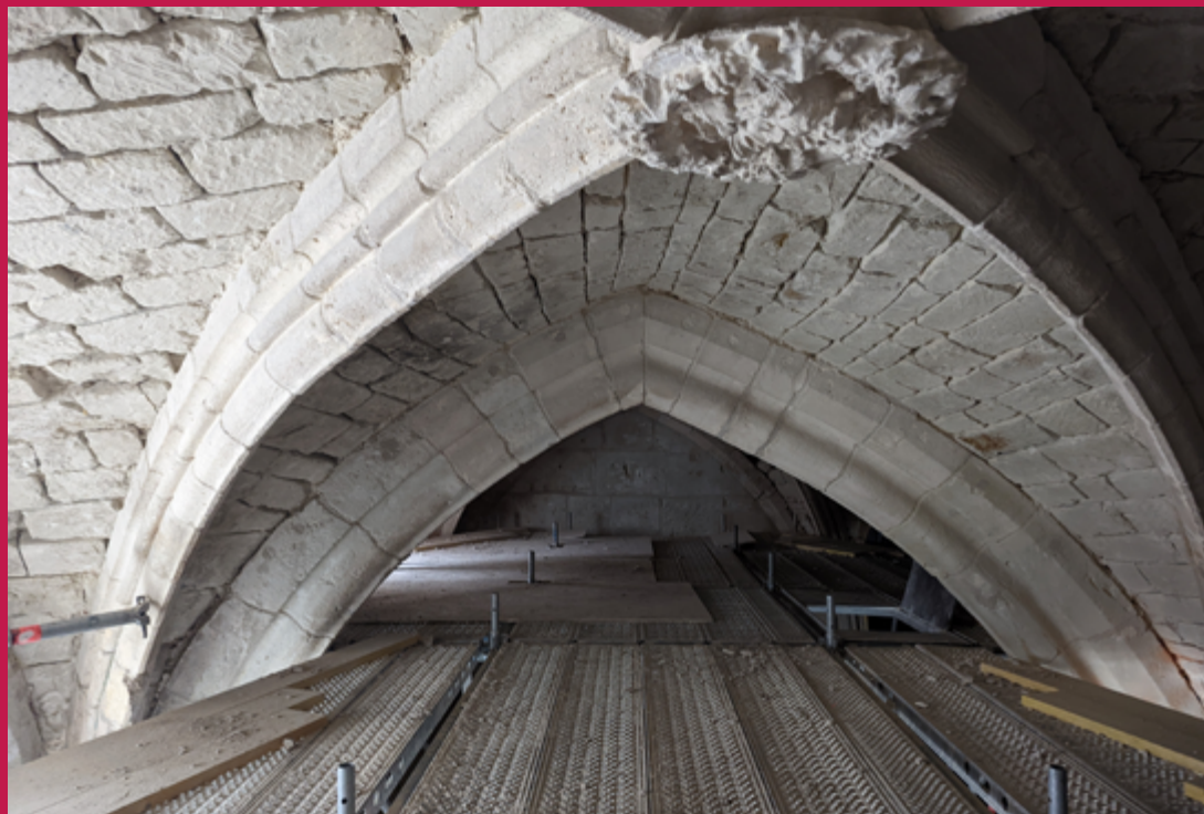
Restauration en cours des voûtes basses du transept nord, décembre 2025.
