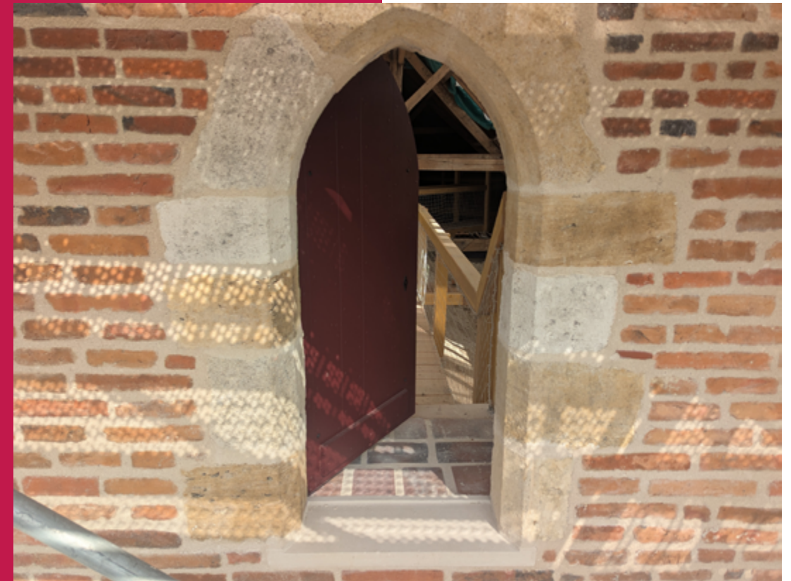
Porte du pignon du bras sud du transept restaurée.
