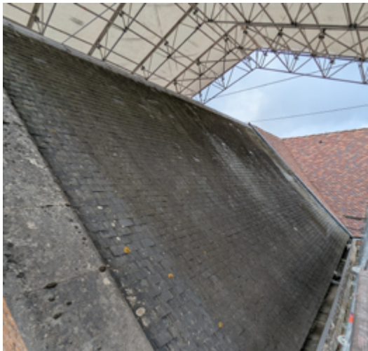
État de la couverture du transept sud en ardoises avant restauration, mars 2025.
