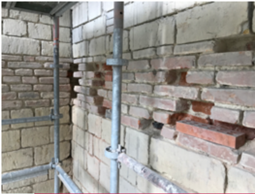
Remplacement des briques en mauvais état par des briques neuves. © Agence Pierre-Yves Caillault, juillet 2020.
