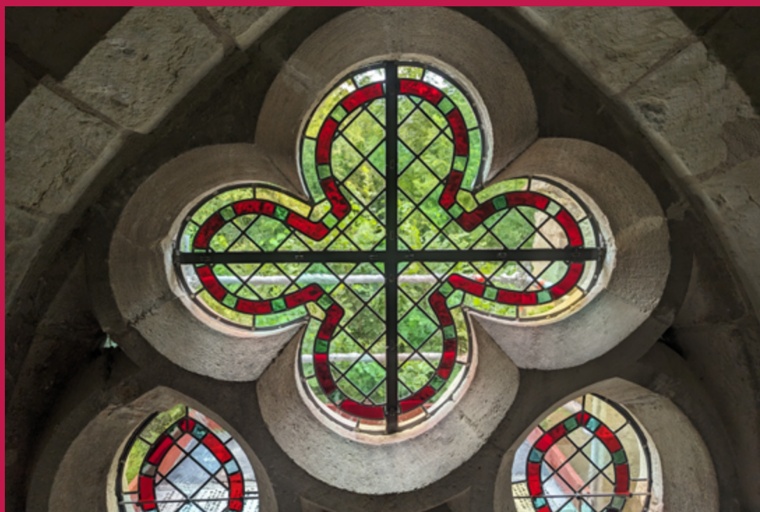
Repose des vitraux dans les réseaux après fabrication, juillet 2023.
