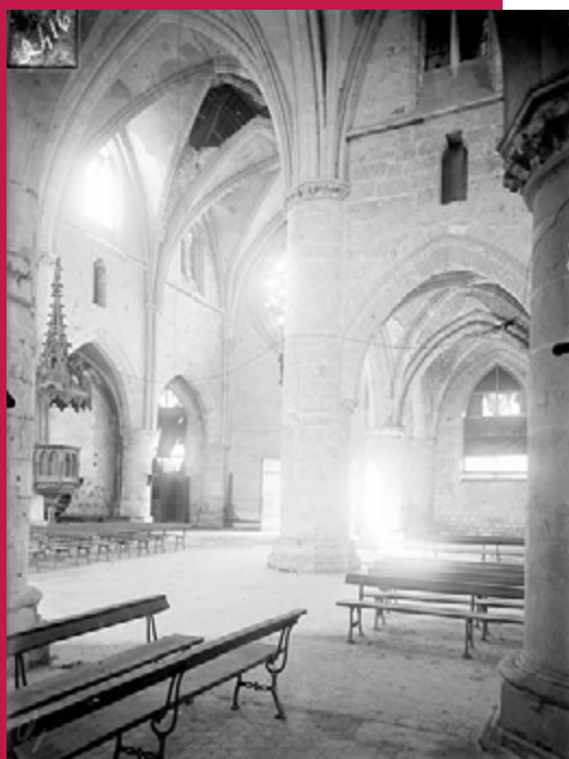
Vue intérieure du bas-côté nord et de la nef, vers le sud-ouest, Paul Queste, avant 1919. © Ministère de la Culture, Médiathèque du patrimoine et de la photographie, APMH00022416.
