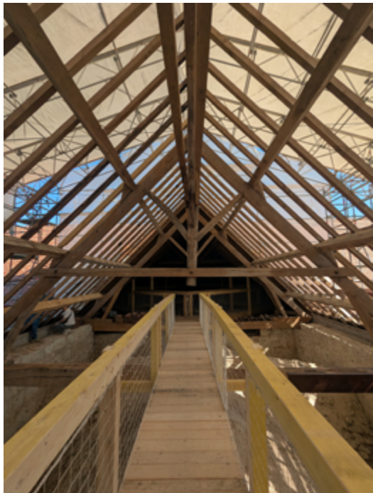
Charpente du bras de transept sud en cours de restauration avec l'ajout d'une passerelle d'entretien, juillet 2025.
