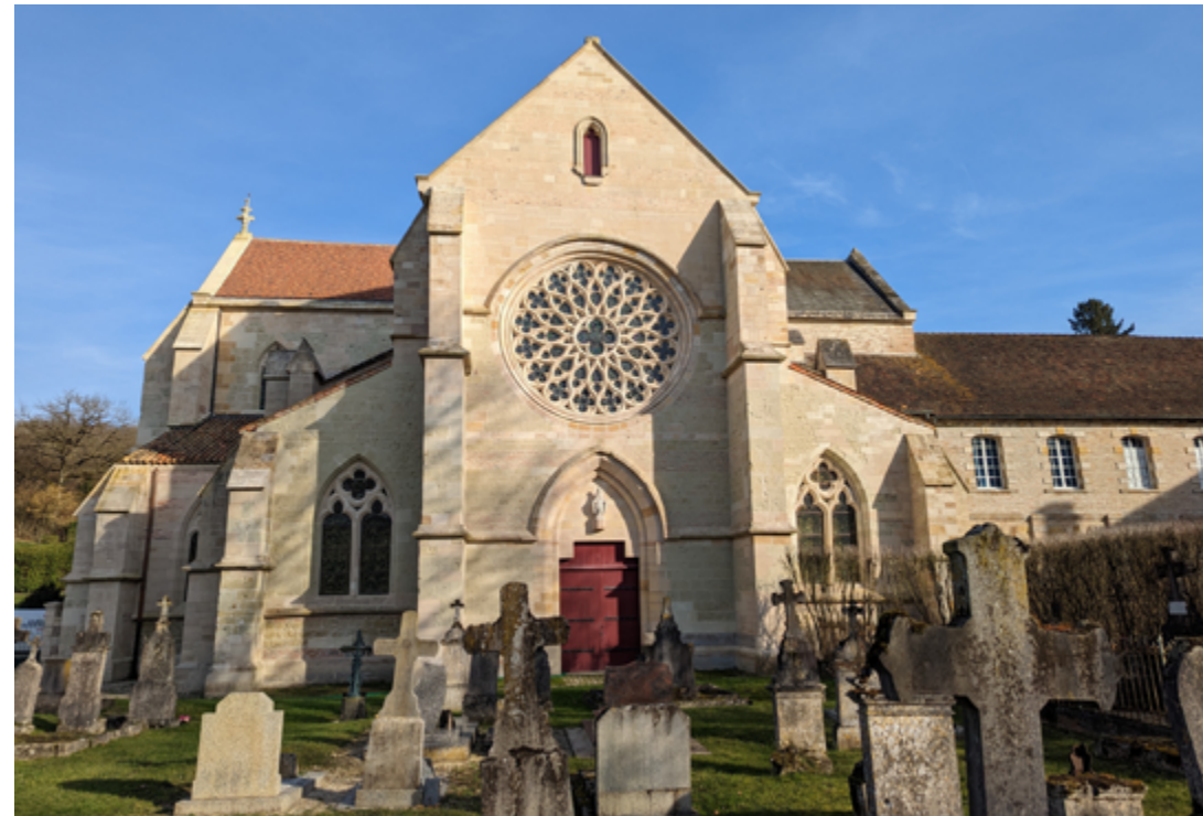
Vue de la façade occidentale avec la couverture du transept non restaurée à droite (en ardoises) et restaurée à gauche (en tuiles), février 2023.
