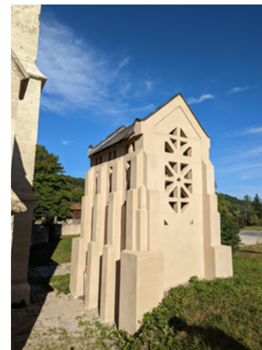
Vue du campanile après restauration, août 2022.
