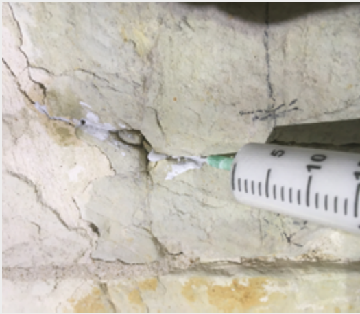
1. injection de micro-coulis à l'aide d'une seringue. © Antonella Trovisi.
