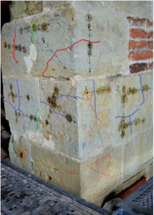
MORTIERS D'INJECTION TESTES
