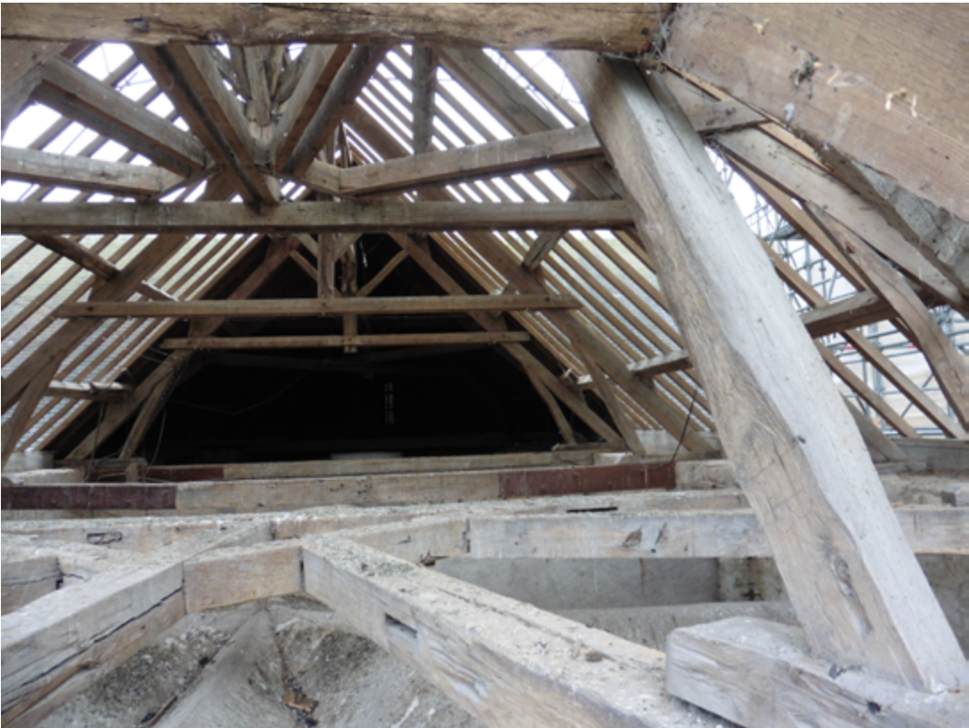
Charpente du chœur en cours de restauration, les reins des voûtes en béton armé sont visibles, 2018. © Agence Pierre-Yves Caillault.
