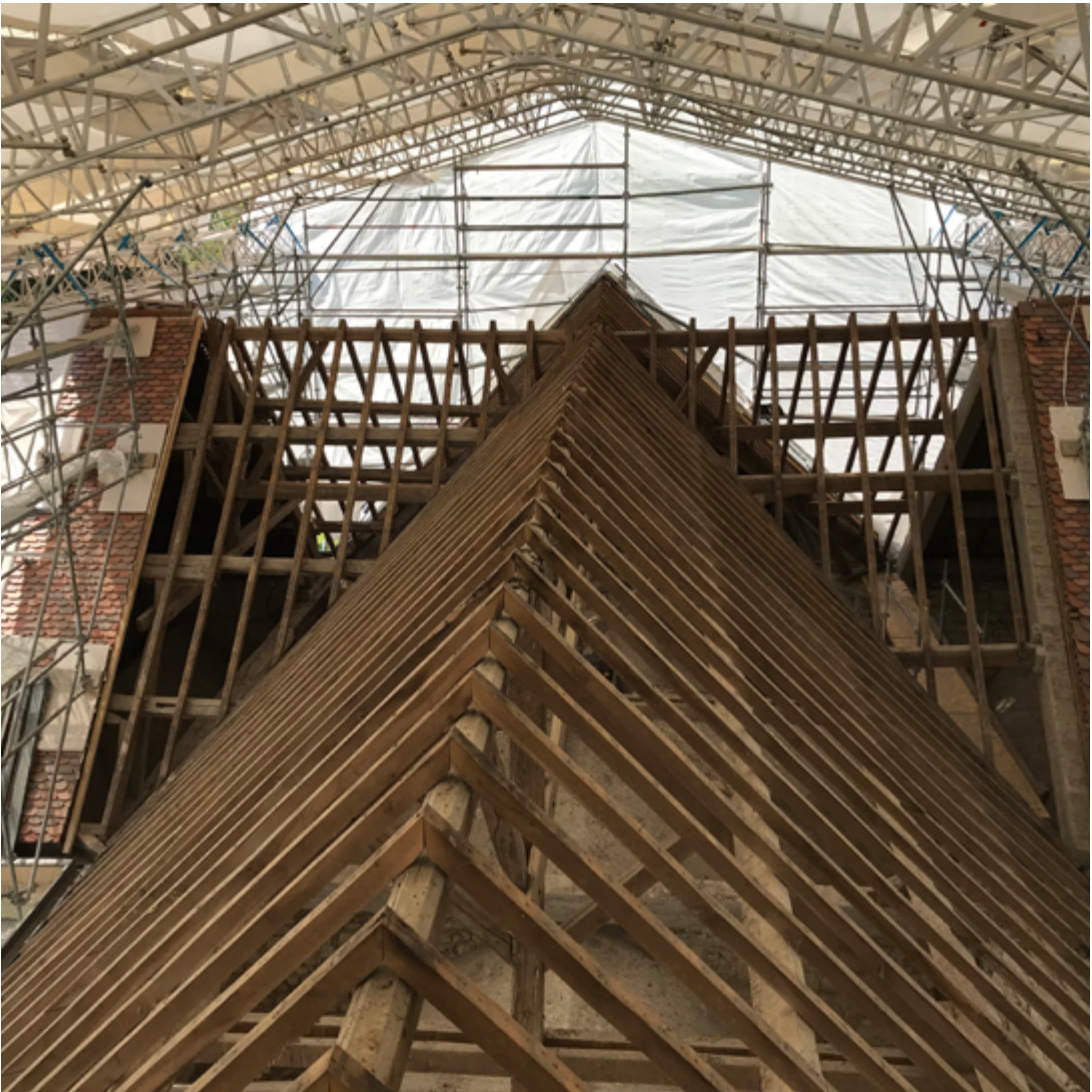
Charpente du transept nord et de la croisée du transept, juillet 2021.
