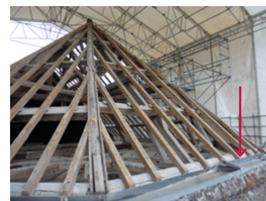
Vue sur le chéneau en béton armé dans le chœur après la dépose de la couverture © Agence Pierre-Yves Caillaud, 2018.
