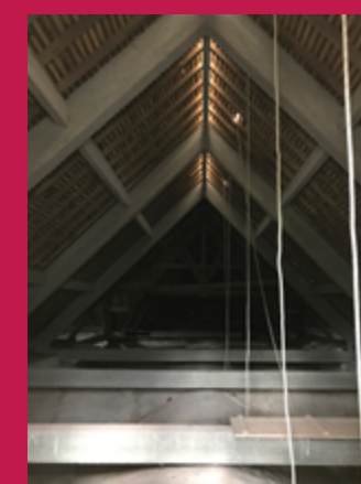
Vue de la charpente en béton armé de la nef, 2020. © Agence Pierre-Yves Caillault.
