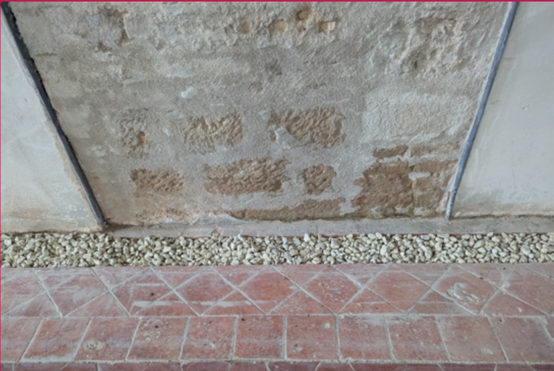
Détail de la tranchée drainante périphérique pour assurer l'assainissement des parements intérieurs.
