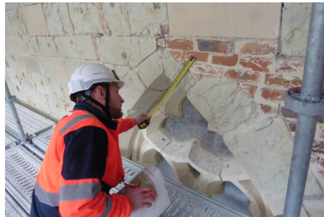
Réalisation d'un calepin du parement en pierre de taille, janvier 2020. © Agence Pierre-Yves Caillault.
