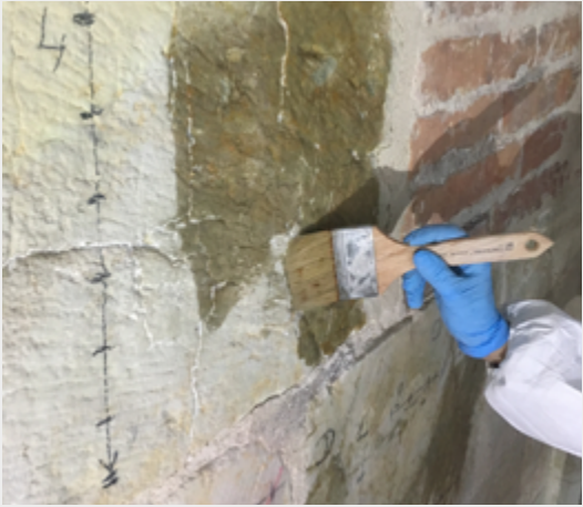
2. application d'un produit de traitement surfacique antihydro. © Antonella Trovisi.
