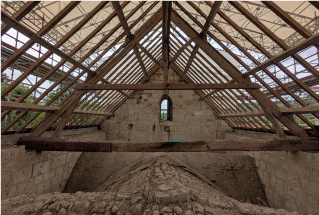
Ferme 7 du transept sud en cours de restauration avec l'entrait médiéval sur lequel reposent les fermes plus récentes, juin 2025. © DRAC Grand Est, CRMH.
