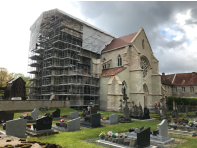
Échafaudages du transept nord, mai 2021. © Agence Pierre-Yves Caillault.
