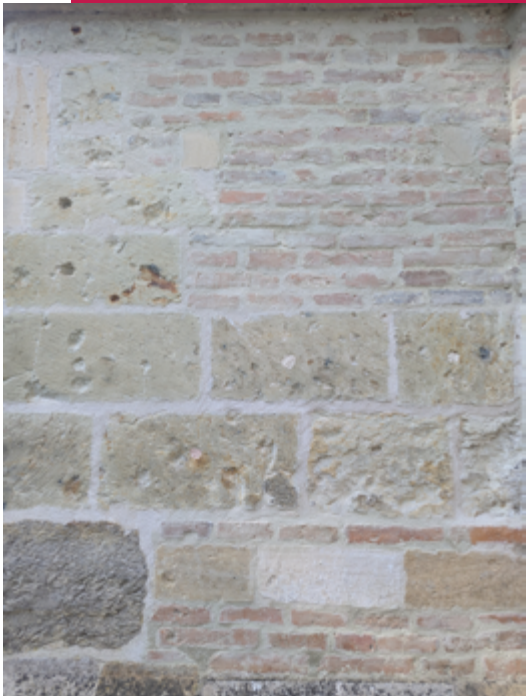
Parement restauré avec un badigeon, mars 2025.
