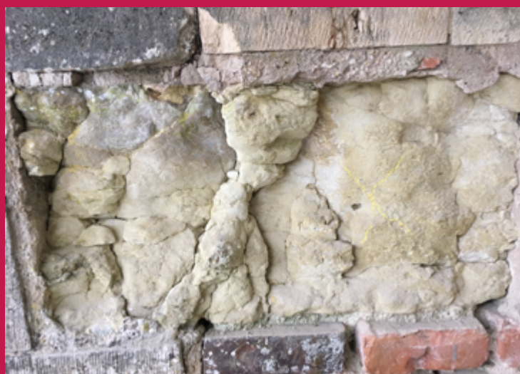
Exemples des différents niveaux d'altérations de la gaize, de la microfissure au délitement complet.
