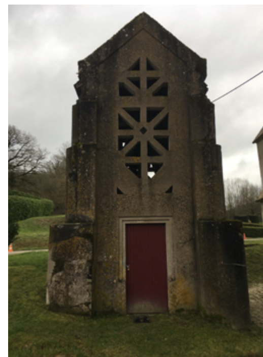
Vue du campanile avant restauration, mars 2021.
