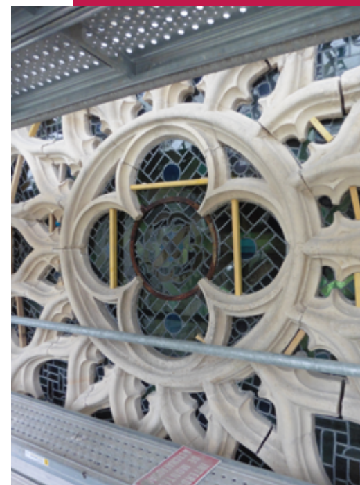
Rosace en cours de restauration, janvier 2020. © Agence Pierre-Yves Caillault.
