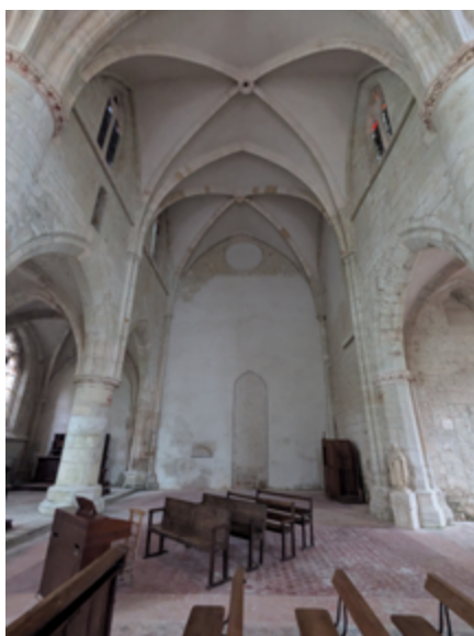
Vue de l'élévation intérieure du transept sud restaurée. L'ancien passage entre l'église et les bâtiments monastiques a été remis au jour.
