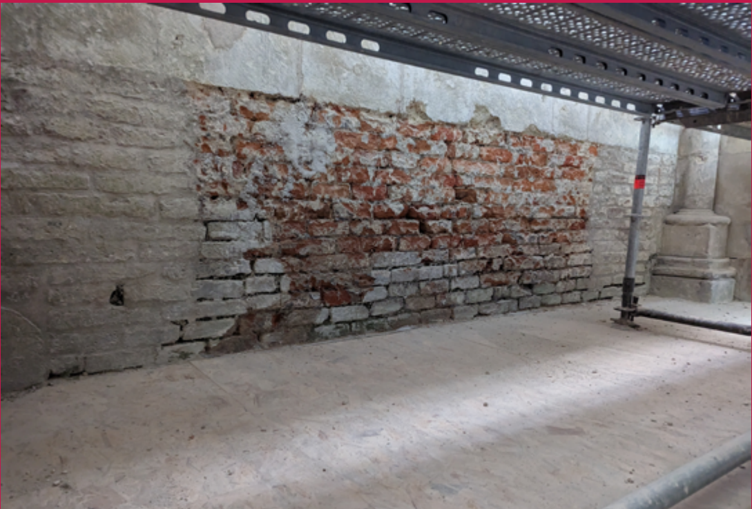
État des parements intérieurs en brique avant restauration.
