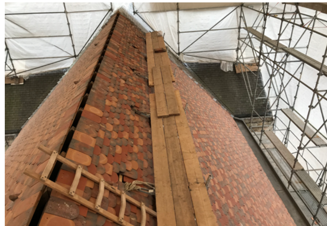
Couverture en tuiles écailles de la nef en cours de pose, juillet 2020 : la couverture en ardoises du transept non restaurée est visible en arrière-plan. © Agence Pierre-Yves Caillault.
