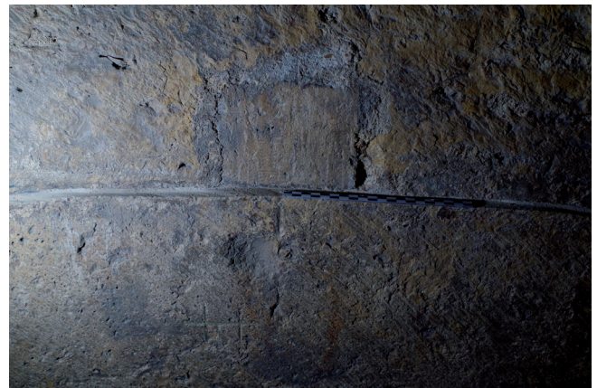
Fig. 2 : Chartres (Eure-et-Loir) cathédrale Notre-Dame, chapelle Saint-Piat : tourelle nord, rez-de-chaussée, trou de boulin surmontant un repère incisé et marque lapidaire. (T. Lacroere, Direction de l'archéologie de Chartres métropole)
