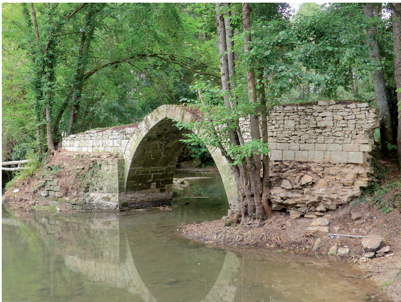
Chambourg-sur-Indre (Indre-et-Loire) Île-Auger : vue du parement sud du pont. (A. Pioger, SADIL)
