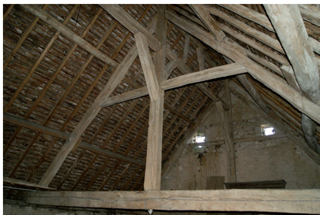
Fig.2 : Vallée du Loir (Loir-et-Cher) : la charpente du prieuré de Lavardin, reprise au XV e siècle dans un bâtiment du XII e s. (E. Marot)
