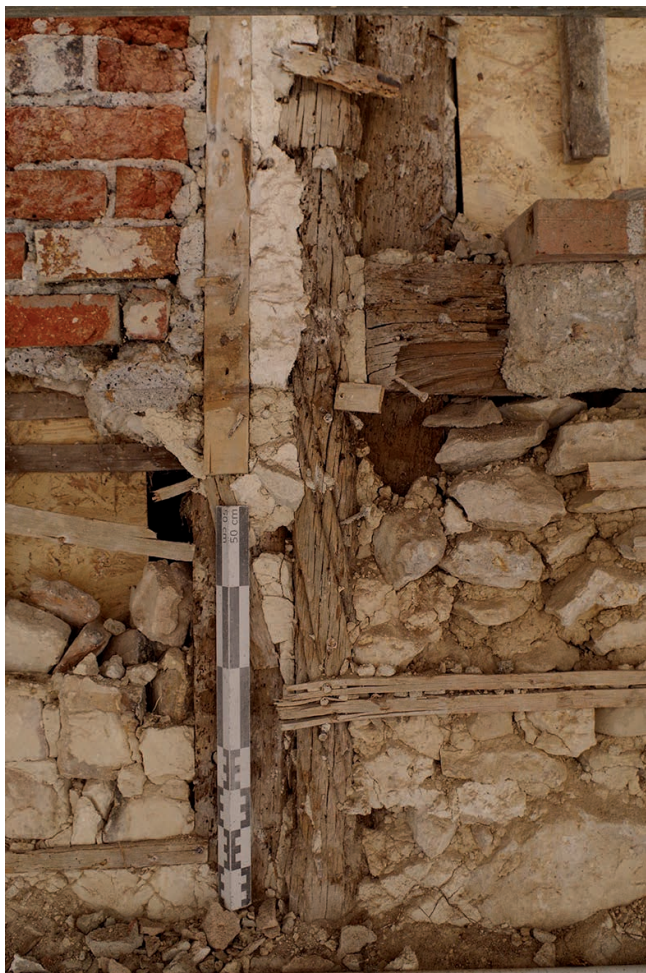
Fig. 2 : Épernon (Eure-et-Loir) 5-7 place du Change : vue d'une colonnette préservée dans la maçonnerie de la façade, premier étage, poteau porteur ouest. (T. Lecroere, Direction de l'archéologie de Chartres métropole)
