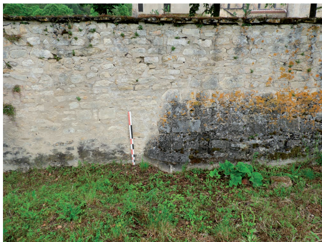
Fig. 1 : Bruère-Allichamps (Cher) abbaye de Noirlac : le mur de terrasse construit en deux temps. (P. Poulle, Inrap)
