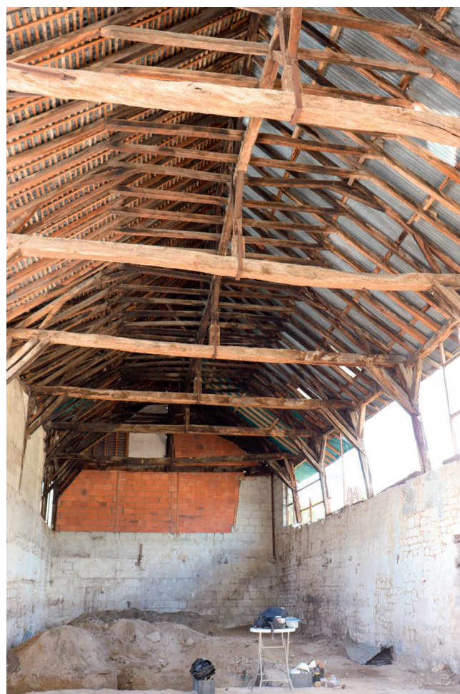
Chinon (Indre-et-Loire) jeu de paume : vue de la charpente, état 2021. (Jean-Yves Dufour, Inrap)
