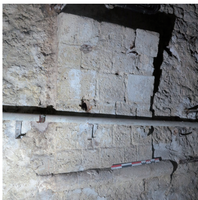
Fig. 2 : Orléans (Loiret) caves du centre-ville : 26 rue Saint-Étienne (SICAVOR 708), quartier cathédral, vestiges de la retombée de l'arc diaphragme supportant initialement le plafond du cellier, XII e s. (C. Alix, Pôle d'archéologie d'Orléans)
