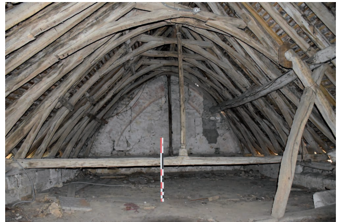
Fig.3 : Vallée du Loir (Loir-et-Cher) : la charpente et le pignon peint de la partie la plus ancienne du prieuré de Lunay (fin XIII e -début du XIV e s.). (E. Marot)
