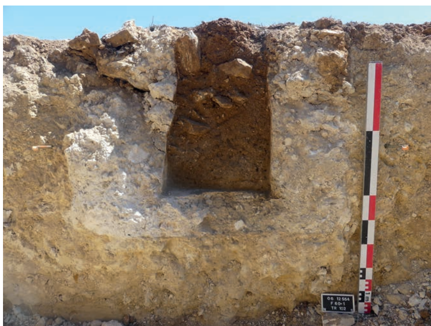
Fig 1 : Bourges (Cher) route de la Charité : coupe de l'aqueduc de Nérigny avec effondrement de sa couverture en partie sommitale du comblement. (Emmanuel Marot, Service d'archéologie préventive, Bourges Plus)
