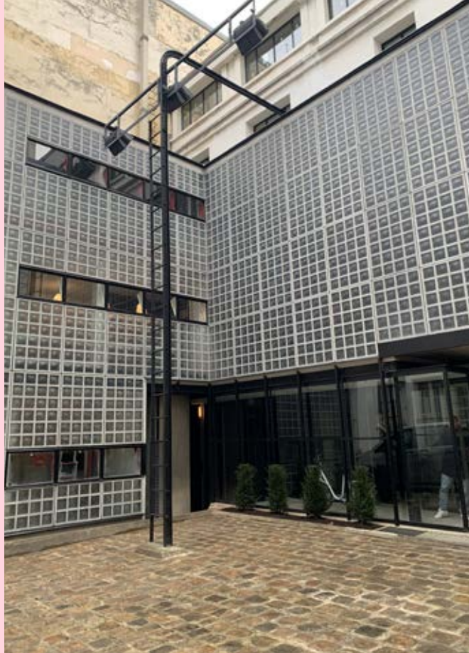
Maison de verre, façade sur cour, Paris 7 e
