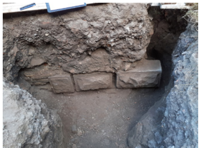
FORT-LOUIS, Fort-carré, front nord-ouest Blocs à bossages du chaînage d'angle arrière (cliché : P. KELLER)
