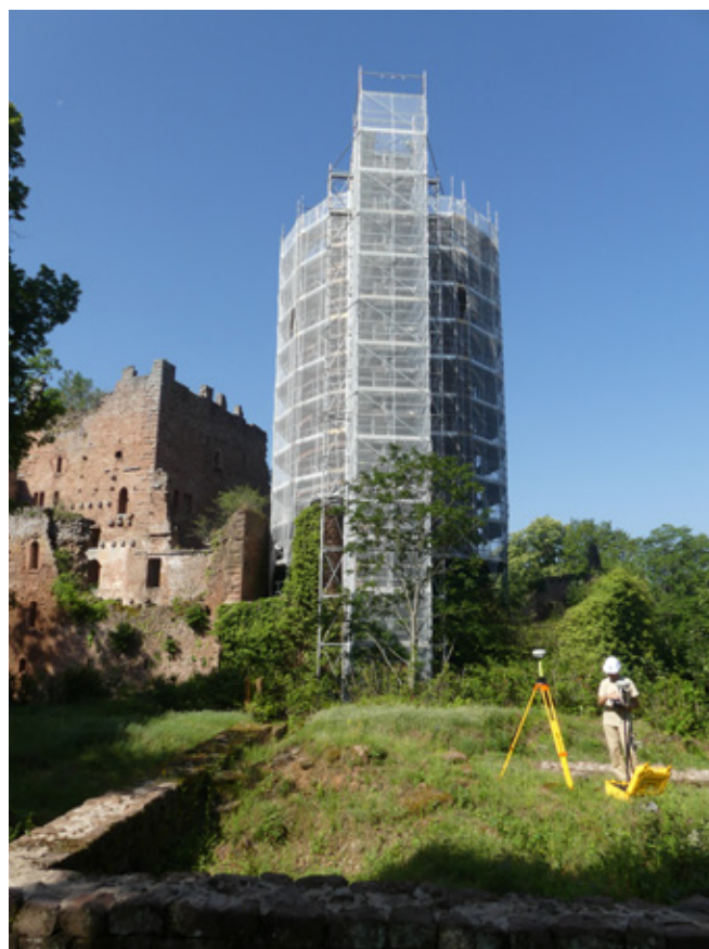
OTTROTT, château de Rathsamhausen, donjon circulaire Vue du chantier, donjon et échafaudage (cliché : J. KOCH, Archéologie Alsace)
