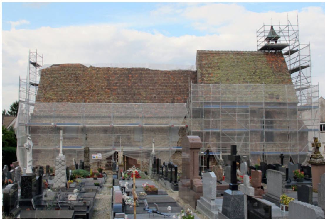
MARMOUTIER, chapelle Saint-Denis, rue du Général Leclerc Vue de la chapelle Saint-Denis au moment des travaux (septembre 2019) (cliché : B. DOTTORI, Inrap)
