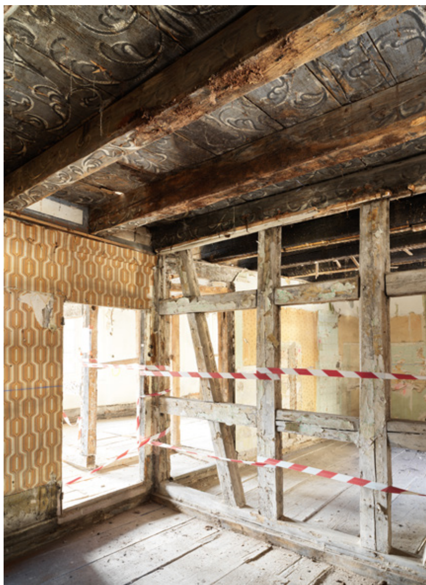
STRASBOURG, 12 rue des Dentelles Immeuble arrière sur cour construit en 1695d : vue de la pièce couverte par un plafond peint (cliché : Région Grand Est – Inventaire général/S. LEVAILLANT)
