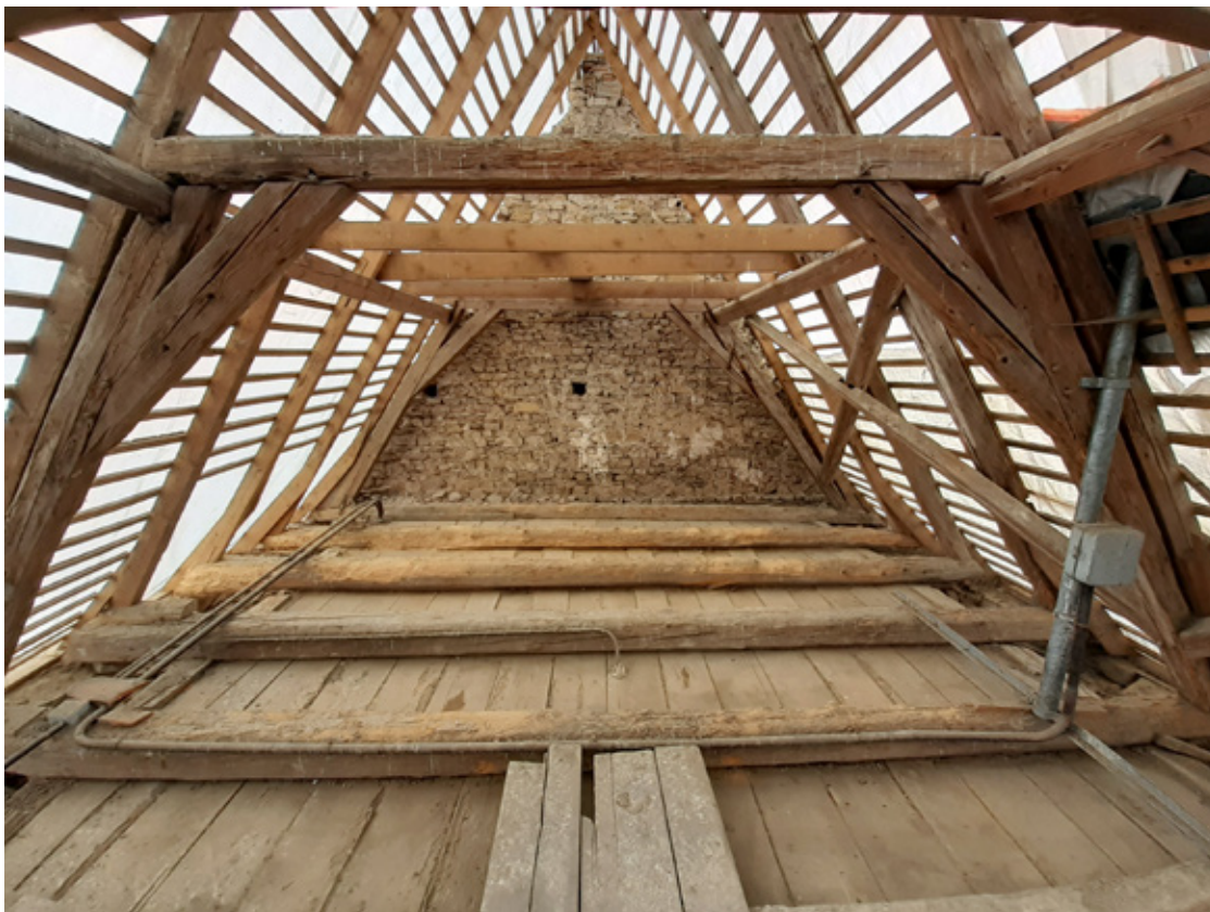
MARMOUTIER, chapelle Saint-Denis, rue du Général Leclerc La charpente de la nef (peu après 1506) (cliché : B. DOTTORI, Inrap)
