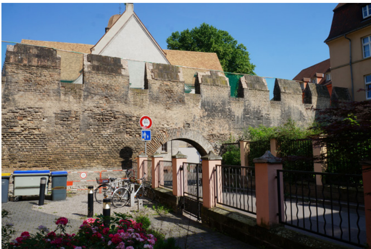
STRASBOURG, place Sainte-Madeleine, rue du Fossé des Orphelins Vue de l'élévation externe du rempart avant travaux (cliché : L. JEANNERET, Archéologie Alsace)
