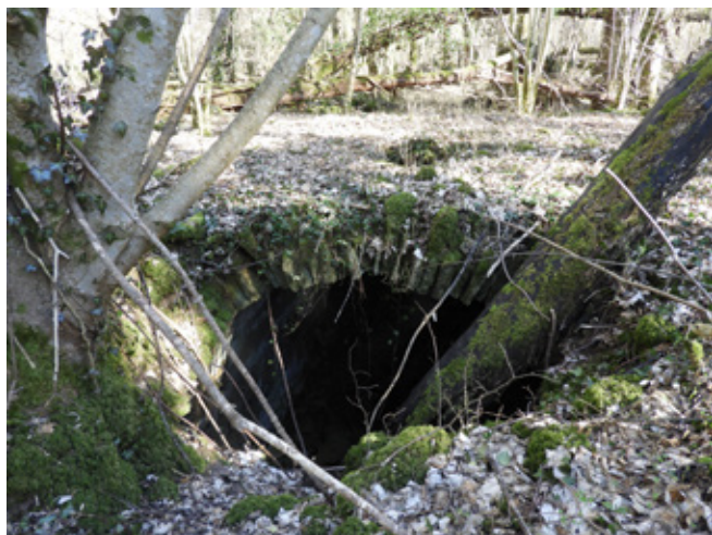
SOMMEVILLE, Devant les Murs Vue du plafond écroulé de la citerne centrale (haut Moyen Âge) (cliché : D. SCHMITTER)
