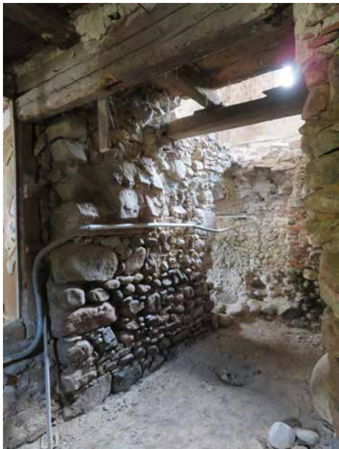
KAYSERSBERG VIGNOBLE, 22 Grand'Rue, rue des Prés, place Gouraud Vue des vestiges de la tour depuis l'intérieur, montrant l'arrachement d'un arc qui couvrait initialement l'ou- verture de la gorge (au premier plan, à gauche) et la meurtrière transformée en porte (au second plan) (cliché : M. WERLÉ, SRA)
