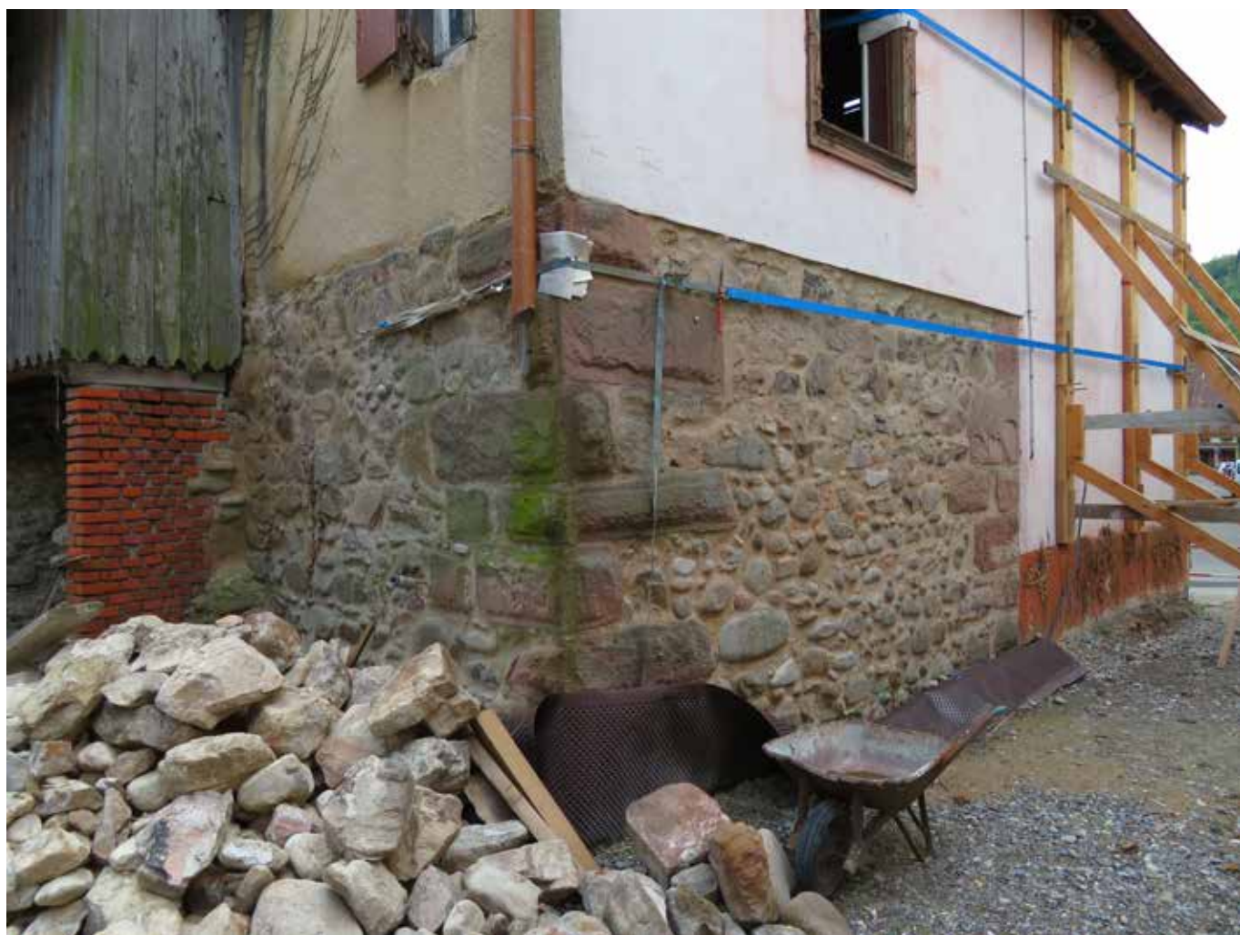
KAYSERSBERG VIGNOBLE, 22 Grand'Rue, rue des Prés, place Gouraud Vue des vestiges de la tour depuis le nord (cliché : M. WERLÉ, SRA)
