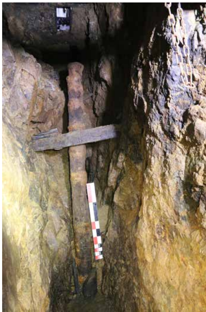
STEINBACH, mine Saint-Nicolas Vue d'un cor , ou tuyau de pompe, cerclé d'anneaux de fer (cliché : B. BOHLY)
