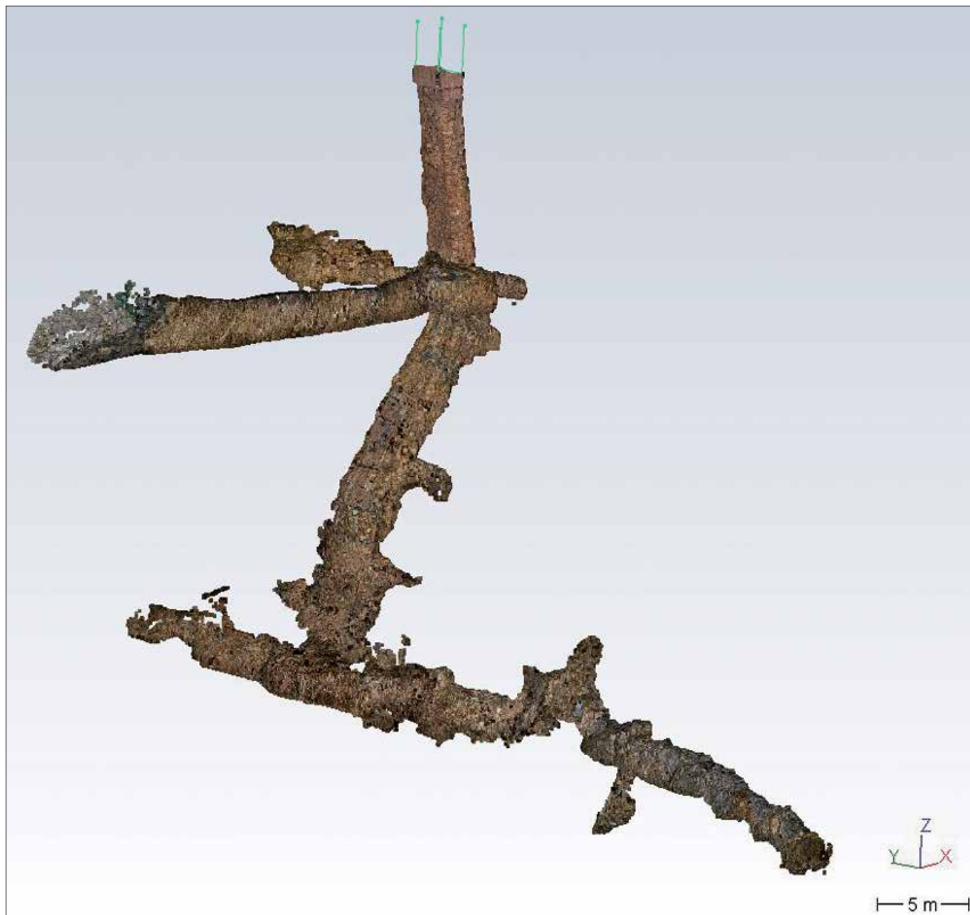
SAINTE-MARIE-AUX-MINES, mine Giro Relevé photogrammétrique du réseau : aperçu du nuage de points (nord = Y) (cliché : J. HECKES, J. GAUTHIER)
