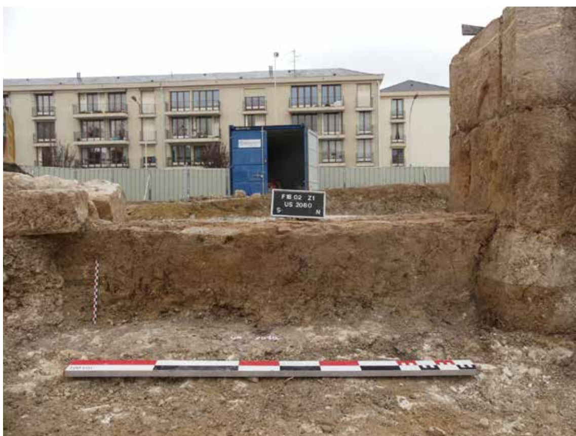
REIMS, parvis de la basilique Saint-Remi Détail de l'accès du bâtiment dit de l'Aumônerie (cliché : Service Archéologique CUGR)
