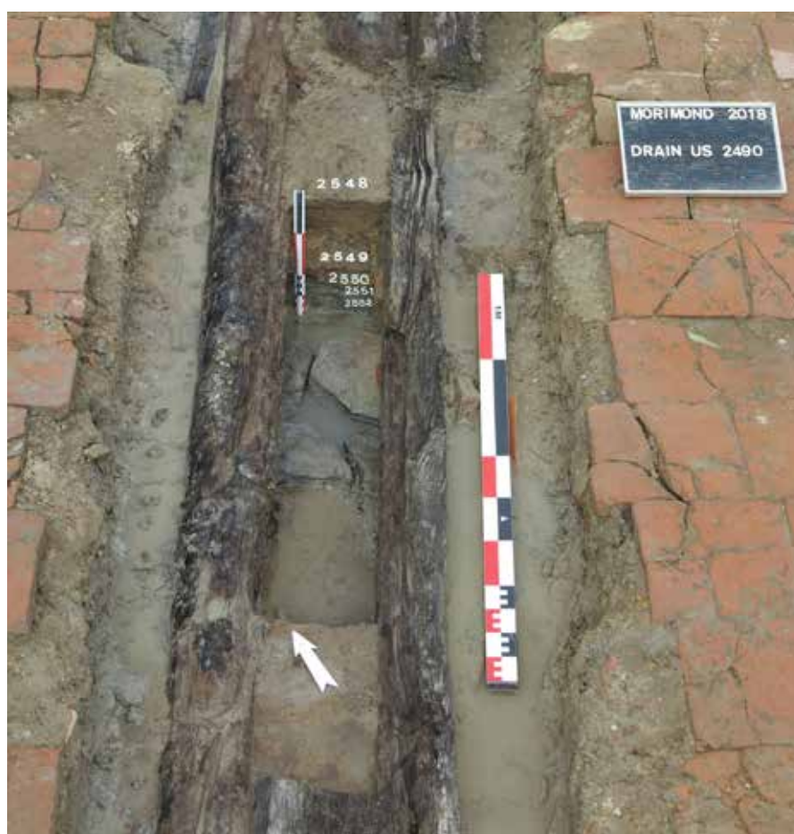
PARNOY-EN-BASSIGNY, abbaye de Morimond La stratigraphie du drain en bois passant sous le bâtiment E (cliché : B. ROUZEAU)
