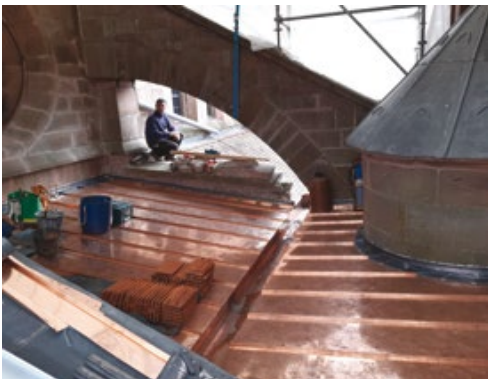
Cathédrale Notre-Dame de Saint-Dié Travaux d'étanchéité des terrasses.
