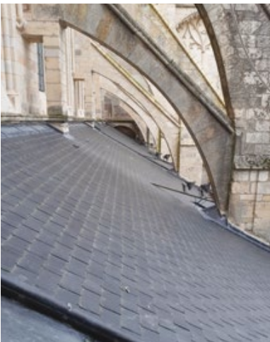
Cathédrale Saint-Étienne de Bourges Restauration des toitures des bas-côtés et des baies hautes côté nord.
