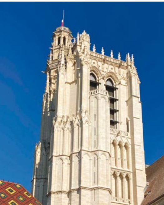
Cathédrale Saint-Étienne de Sens Restauration de la tour sud et du portail.
