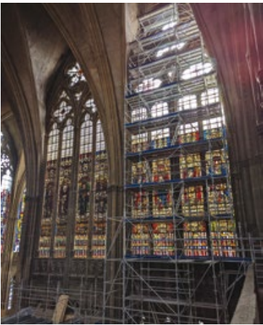
Cathédrale Saint-Étienne de Metz Travaux d'urgence du transept nord.
