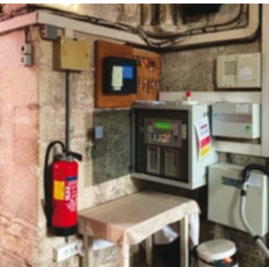
Cathédrale de Meaux, de Saint-Denis et de Versailles Audit incendie et travaux d'urgence.
