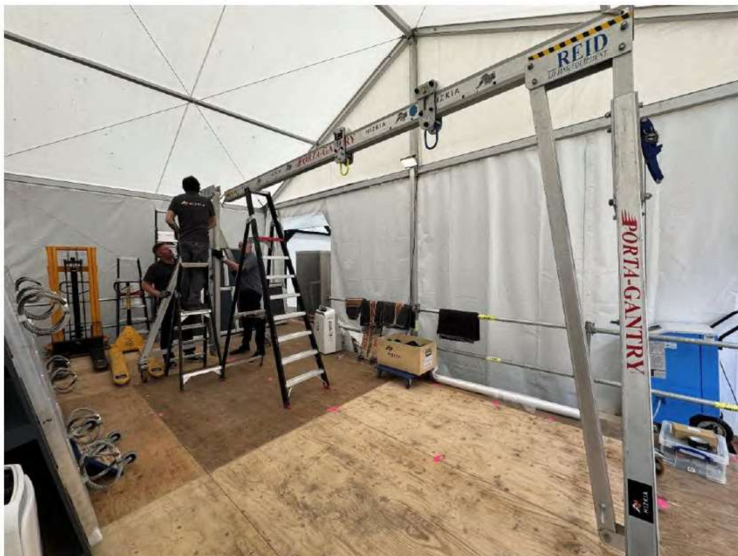
Figure 66 : Manipulateurs HIZKIA installant le portique de levage sur la plateforme de manipulation installée en face des réserves de la Tapisserie. Trajet d'avril 2026. ©SMACH
