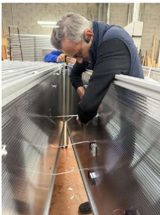
Figure 64 : Installation des 5 capteurs StaRT sur le panneau 2 par un opérateur SMACH. Trajet de février 2026. ©SMACH
