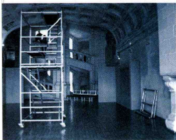
Les observations et les relevés sont réalisés à partir d'un échafaudage placé dans les salles
