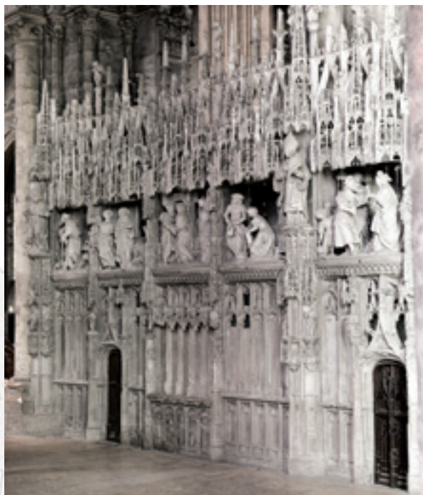
Tour de chœur : premières travées sud
