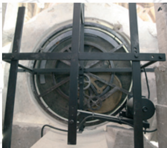
Nouveau mécanisme en place
