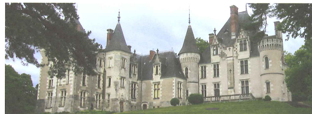
Façade ouest du château
