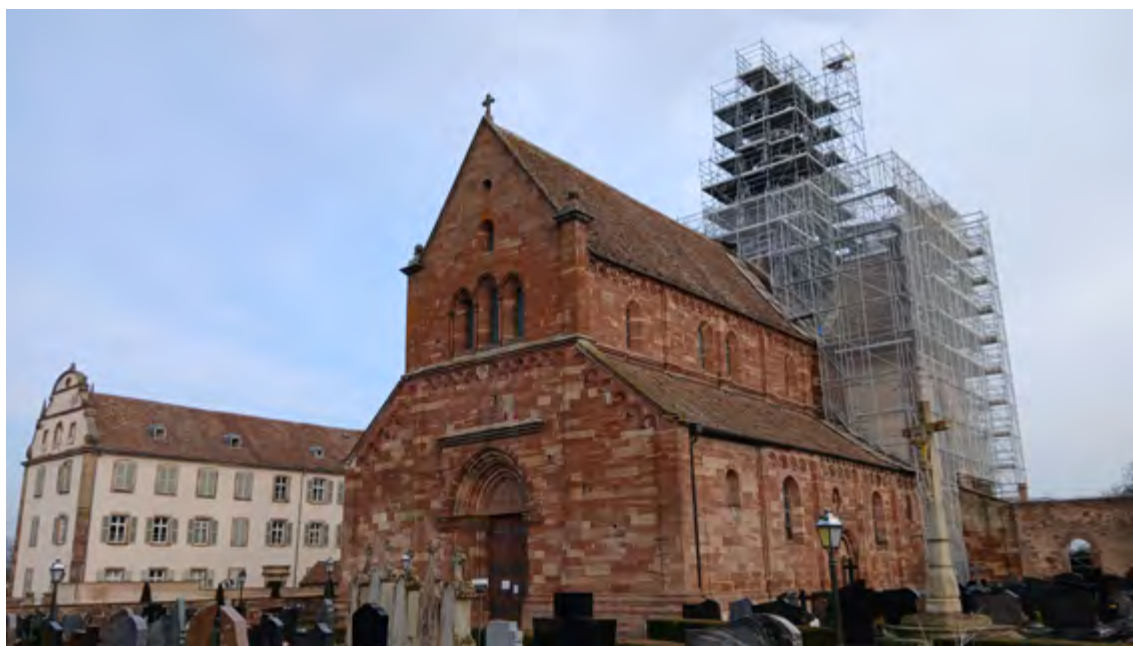
L'abbatiale Saint-Cyriaque d'Altorf - Travaux de restauration sur les toitures de la nef et du chœur © DRAC Grand Est
