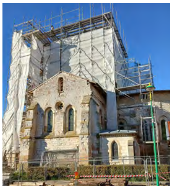
Restauration du clocher de l'église Saint-Laurent de Dampierre-sur-Moivre (Marne) © DRAC Grand Est
