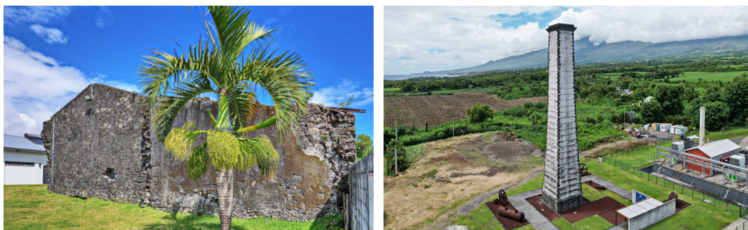
Usine de Beaufonds © Fondation du patrimoine - Myphotoagency - Christian Bersano
