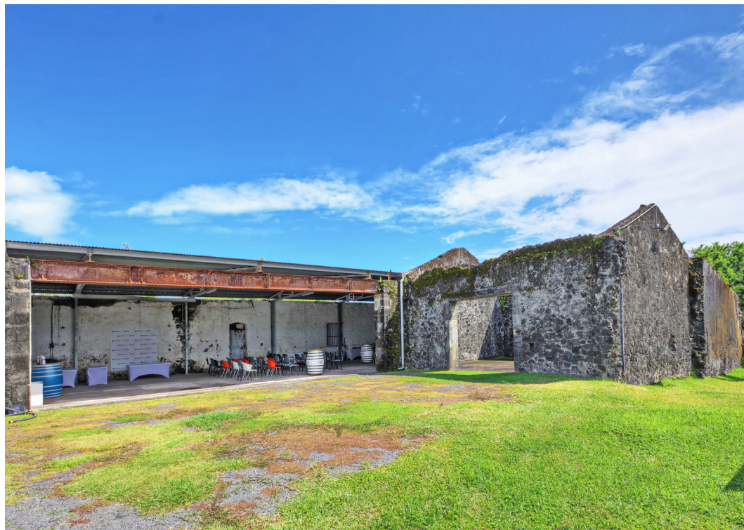
Usine de Beaufonds © Fondation du patrimoine - Myphotoagency - Christian Bersano
