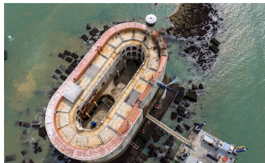
Fort Boyard © Imagine Créations - Groupe ETPO - Architecture Patrimoine
