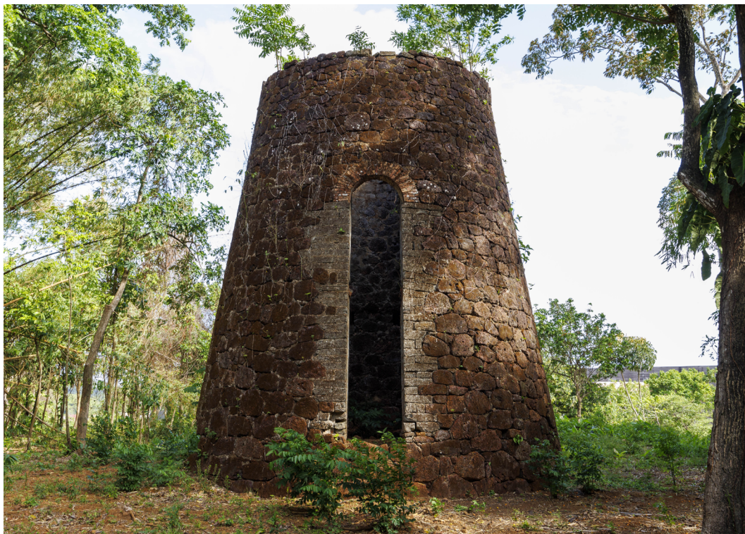
Moulin de l'habitation Loyola © Fondation du patrimoine - Myphotoagency - Ronan Liétar
