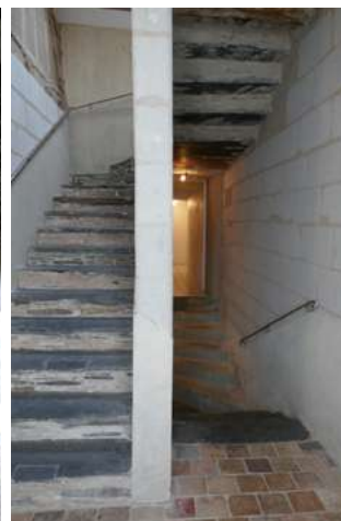
Mur noyau en tuffeau
