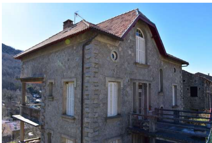
Construction atypique présentant une toiture complexe couverte de tuiles canal.
