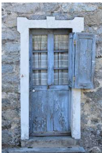
A Santu : encadrement d'une porte d'entrée en surépaisseur d'enduit avec découpage particulier, peint en blanc.
