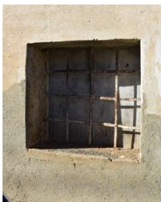
Grille à barreaux croisés.
