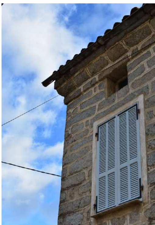
Gouttière en zinc
