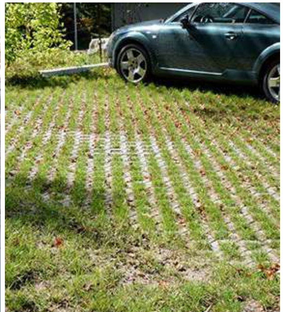
Dans certains cas, une solution alternative de dalles alvéolaires enherbées pour le stationnement des véhicules peut favoriser l'intégration patrimoniale de ces espaces.
