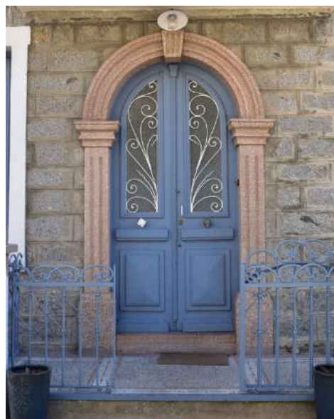
A Santu, porte à panneaux menuisés et ajourés munis d'une grille décorative à volutes, encadrement en granit rose.
