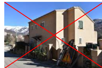
Ci-dessus, construction contemporaine présentant des retraits et saillies peu traditionnels à Bastelica. Il est nécessaire de privilégier les formes simples pour les nouvelles constructions.
