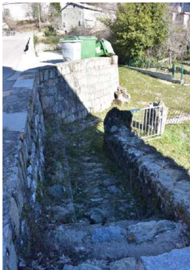
Parapet maçonné en pierres hourdies -granit- formant garde-corps à Santu.
