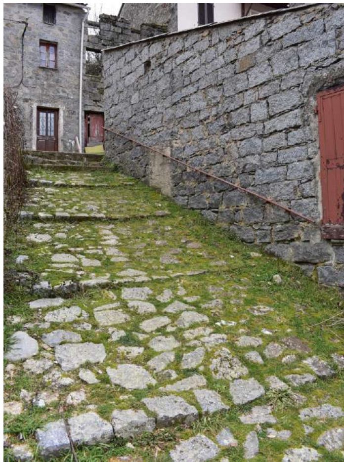
Pas-d'âne dans le quartier de Vassalacci avec main courante installée contre la construction voisine à Vassalacci
