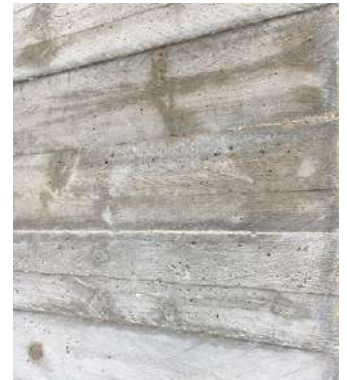
Béton «planchette». Le béton est mis en oeuvre de manière coulé, entre deux planches de coffrage : la veine du bois fait matrice et s'imprime sur le béton, lui donnant un aspect organique.
