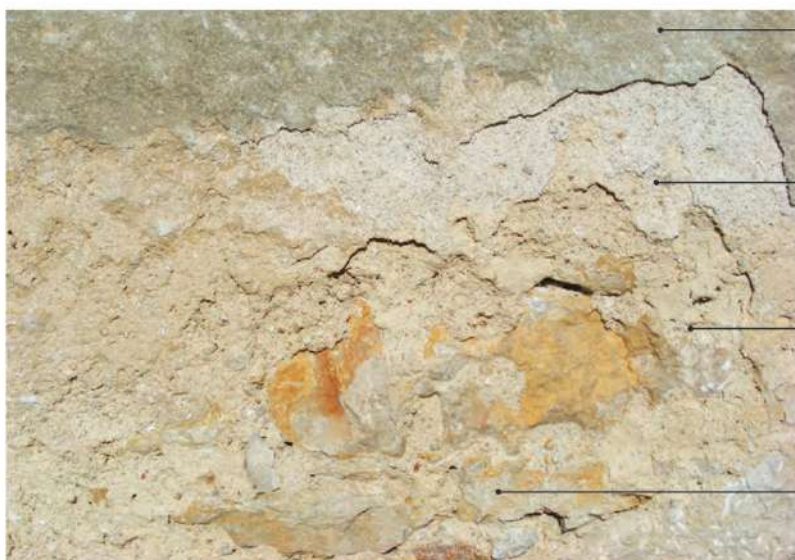
Mur en blocs de granit taillés posés sur assises irrégulières, appartenant à une construction ancienne. Le choix d'un enduit à pierre-vue a privilégié une pose avec joints légèrement creux. Le choix du coloris est important : dans ce cas il est légèrement trop clair.
