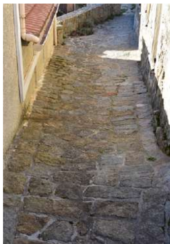
Ruelle étroite assurant une canalisation des eaux de ruissellement par un profil convexe.
