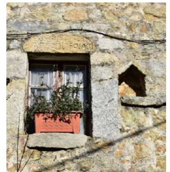
Ci-dessus : à Santu, pierre gravée surmontant une baie. Présence d'une niche avec pierre en console pour le pot de nuit.
