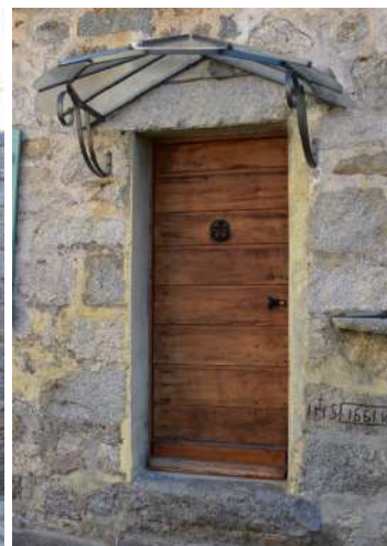
Marquise en fer forgé et vitrage à Tricolacci
