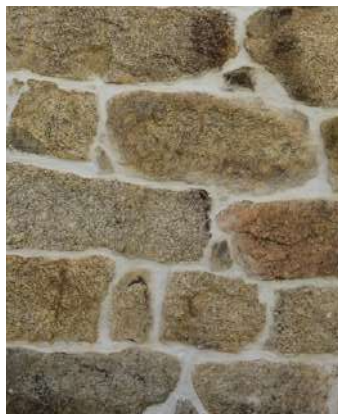
Mur en blocs de granit taillés posés sur assises irrégulières, appartenant à une construction ancienne. Le choix d'un enduit à pierre-vue a privilégié une pose avec joints légèrement creux. Le choix du coloris est important : dans ce cas il est légèrement trop clair.
