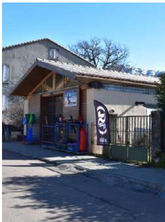
Activité de location de matériel de ski à Bastelica : l'enseigne et les stands à l'extérieur peuvent être améliorés en vue de favoriser leur intégration patrimoniale.
