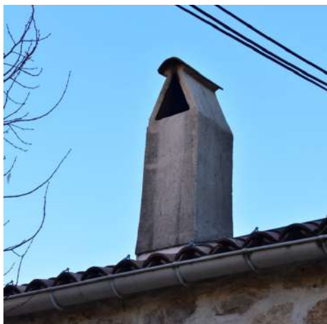
Conduit maçonné en toiture avec couronnement pyramidal. Le couronnement est, de préférence, réalisé avec des tuiles. La finition de la souche doit rappeler les matériaux mis en oeuvre sur les façades de la construction à laquelle elle se rapporte.
