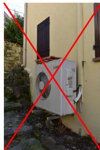
A Santu : unité extérieure de pompe à chaleur installée en saillie sur la construction et encombrant le passage public. Les ouvrages en saillie peuvent être intégrés à une maçonnerie faisant office de banc de convivialité lorsque la hauteur le permet ou encore de jardinière. Les réseaux filaires en façade doivent être intégrés à la façade ou rapprochés au maximum des descentes d'eaux pluviales.
