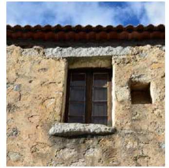
Ci-dessus : à Dominicacci, exemple de linteau et d'appui de fenêtre en pierre sur la même façade et niche à pot de chambre.
