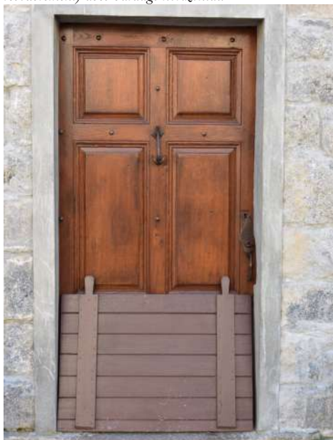
Porte à panneau de bois menuisée. La porte dispose d'un panneau en bois amovible limitant les entrées d'air et d'eau en bas de porte et les déjections canines, à Tricolacci
