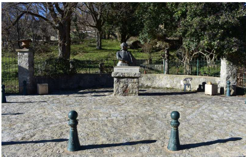
Moellons de granit posé en riccata formant la placette du buste de Sampiero et le parvis d'entrée du manoir de la famille Costa à Tricolacci.
