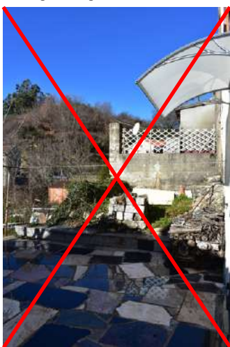
A Santu : terrasse réalisée probablement avec des dalles de récupération posées en opus incertum. Le choix du marbre n'est toutefois pas traditionnel.
