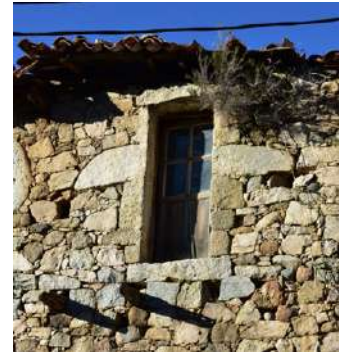
Ci-dessus : à Tricolacci, autre exemple de ré-emploi de pierre de meule, cette fois-ci en clé de jambage.
