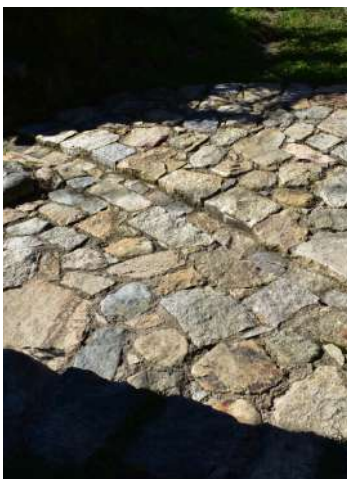
Détail d'ouvrage maçonné en pierre pour l'écoulement des eaux de ruissellement à Santu, sur un chemin communal.
