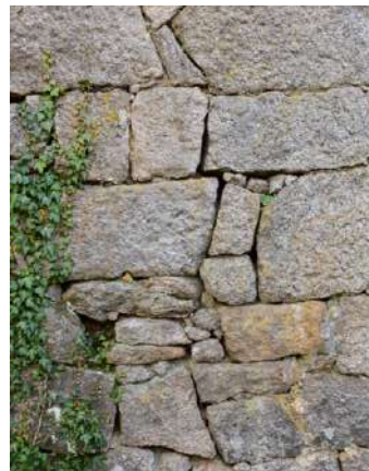
Mur en pierre avec «cugnoli» (petits éclats de pierre aux interstices).
