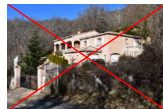
Ci-dessus, construction contemporaine présentant des volumes complexes, toitures quatre pentes et loggias non traditionnels à Bastelica.
