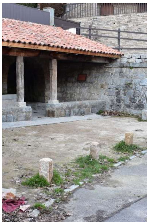
Chasse-roue en granit protégeant des voitures la place de la fontaine de Costa.
