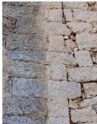
Jonction entre deux constructions présentant deux qualités de taille de pierre.
