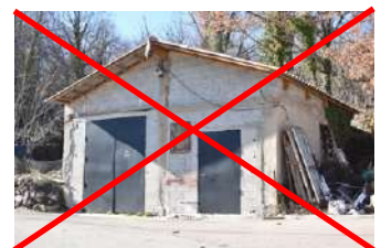
Construction isolée présentant le mur pignon sur rue. Cette disposition n'est toutefois pas traditionnelle. A Bastelica, les constructions présentent leur mur de long-pan parallèlement aux courbes de niveaux et aux espaces publics.
