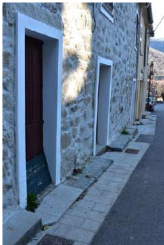
A Costa : les pieds d'immeubles ont été rénovés en dalles de granit avec pose régulière. Le choix du grain et de la couleur de la pierre est important : ici il n'est cependant pas traditionnel.
