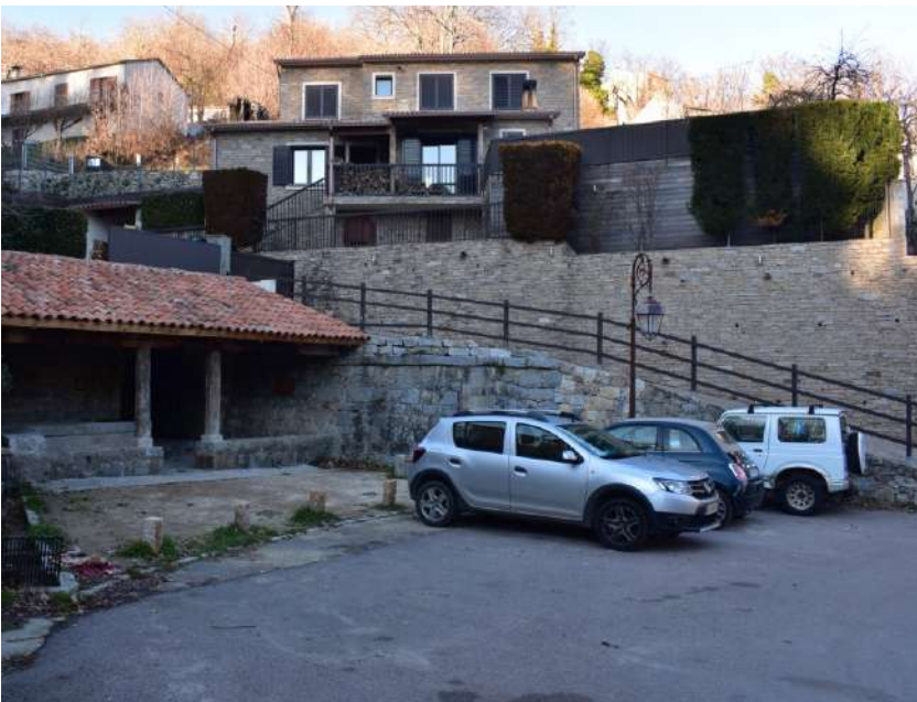
Ci-dessus, espace de stationnement à proximité de la fontaine entre Costa et Tricolacci. L'absence de traitement qualitatif au sol porte préjudice au cadre patrimonial villageois.
