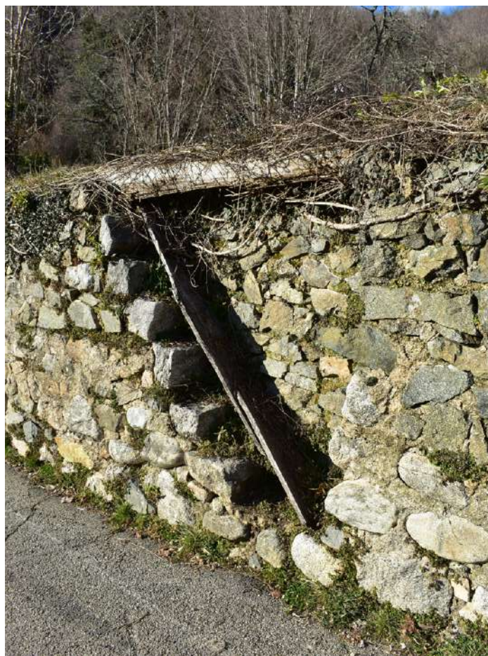
Entre Dominicacci et Castagniccia, mur de soutènement en pierre sèche avec escaliers de jonction inscrit dans l'épaisseur du mur, parallèlement à celui-ci.
