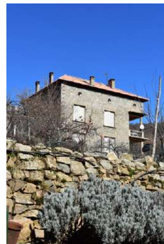
Les toitures à quatre pentes, ne concernant que certaines constructions remarquables, ne sont pas à encourager pour les nouvelles constructions.
