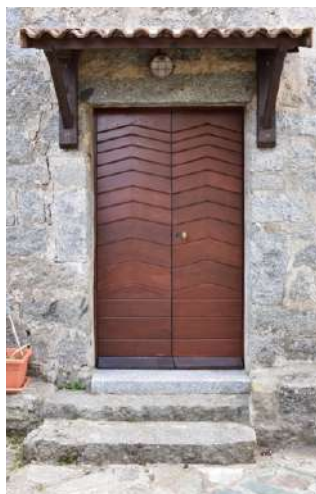
Exemple de marquise avec charpente en bois surmontée d'une couverture en tuiles.
