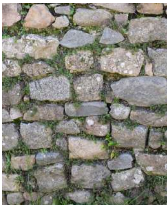
Mur en moellons de granit pour la réalisation d'un mur de soutènement. Posés à sec. Le moellon de granit est un «tout venant». La mise en oeuvre prévoit généralement la pose de pierres plus importante en partie basse de l'ouvrage.
