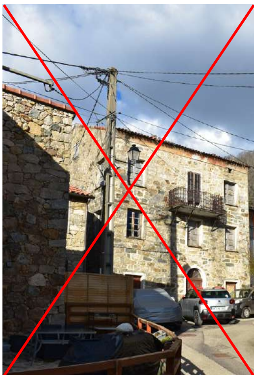
A Dominicacci, pylone en béton et réseaux aériens portant préjudice aux points de vue rapprochés du coeur historique du quartier.
