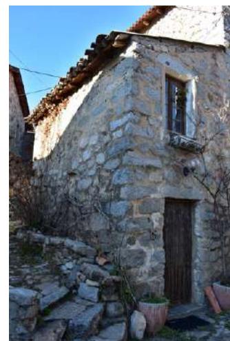
Appenti présentant une simple pente recouverte de PST et tuiles canal
