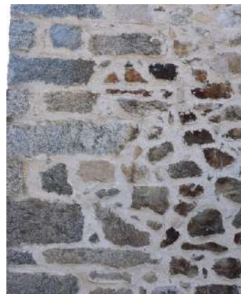
Mur présentant les caractéristiques constructives traditionnelles en façade : avec blocs de granit taillés posés sur assises régulières et formant l'angle de la construction et moellons de granit hourdés. Le choix de couleur de l'enduit reste légèrement trop clair.
