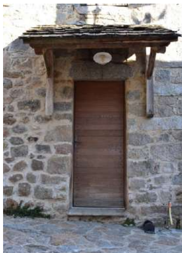
Marquise couverte de scandule à Tricolacci
