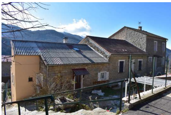
Constructions en bande avec toitures à deux pentes. Couvertures en tuiles plates et plaques de sous-toiture.
