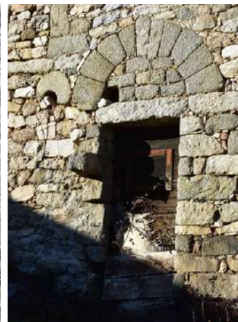
Ci-contre : linteaux, jambages et seuils de portes en granit à Bastelica (quartiers de Boccialacce et Tricolacci).
