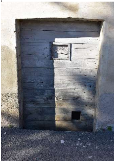
Porte de cave ou d'écuries avec baies de ventilation Tricolacci
