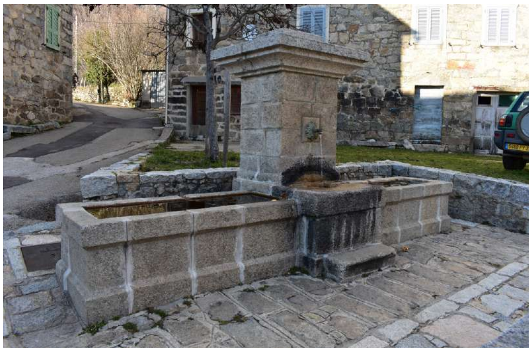
Dalles de granit avec pose régulière formant placette autour de la fontaine dans le quartier de Castagniccia.
