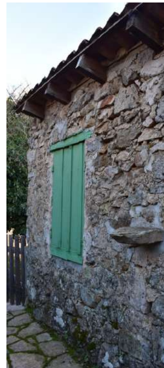
Débord de toiture finissant un faîtage de toiture en appenti.
