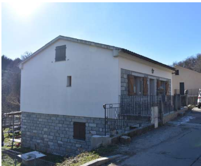
Construction semi-enterrée moderne dans le quartier de Boccialacce, faîtage parallèle aux courbes de niveau, alignement en retrait de l'espace public.
