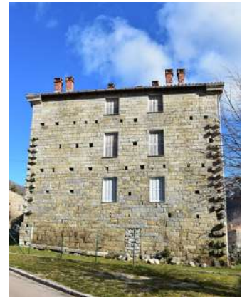
Ci-dessus : à Dominicacci, trous de boulins et pierres d'attente caractérisant la maison de notable de la famille Ambrosini.
