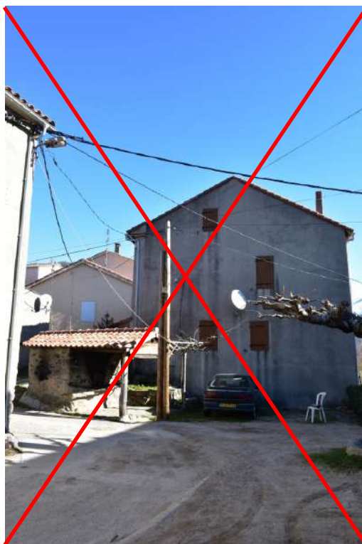
A Santu, double pylone en bois et réseaux filaires entre les constructions nuisant à la qualité patrimoniale de la placette du four à pain.
