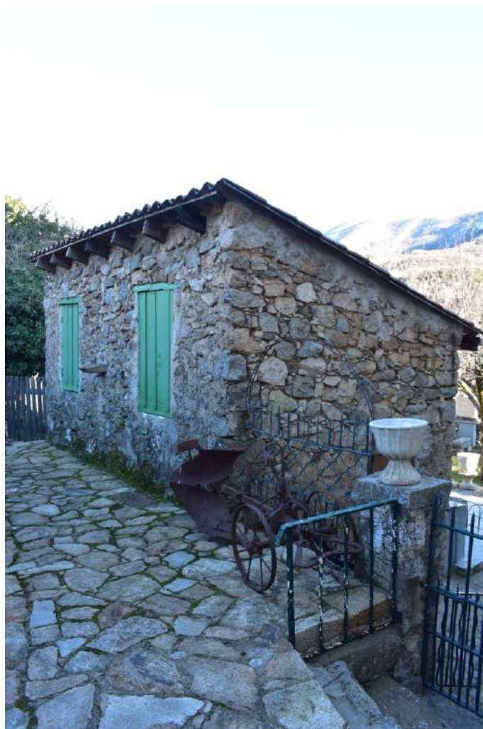
Construction présentant une toiture à simple versant recouverte de tuiles canal
