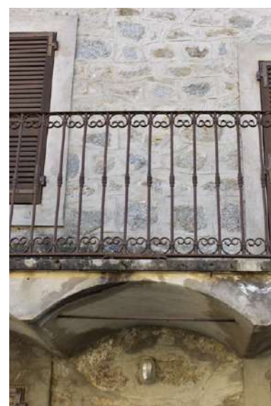
Balcon sur voutains en briques enduites et IPN surmonté d'un garde-corps en fer forgé à barreaux droits avec décor discret de volutes.
