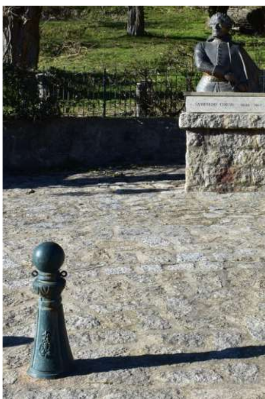
A Tricolacci, chasse-roue en fonte de style 19e protégeant le placette du buste de Sampiero.
