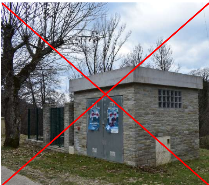
Dans ce cas, à Acqua Grossa, l'édicule ne répond à aucune des caractéristiques bâties de Bastelica (toiture terrasse, briques de verre, placage pierre de type plaquette...)
