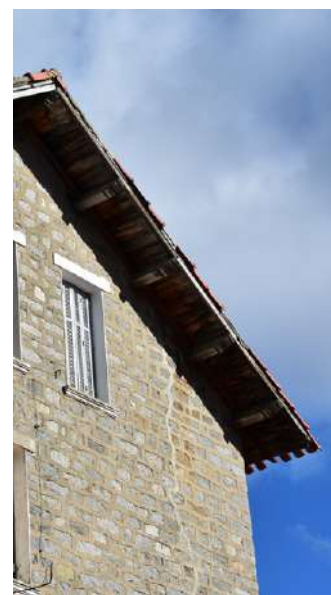
Débord de toiture le long de rives d'une construction remarquable.
