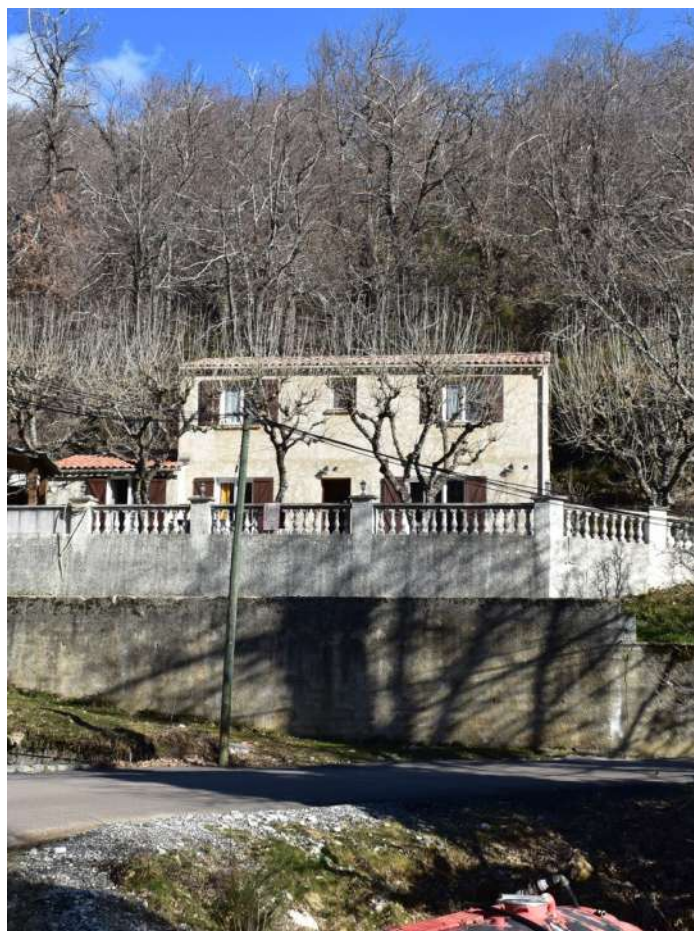
Sur la route de Castegnetto, ouvrage de soutènement en béton enduit au ciment : ce type de réalisation est à proscrire. Pour l'améliorer, une végétalisation par des plantes grimpantes peut être une solution.
