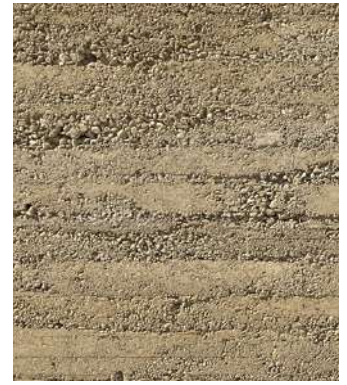
Béton de site : l'effet recherché est celui de la texture et de la couleur se rapprochant des coloris minéraux locaux. Le béton est compacté à sec, sur une grande épaisseur.
