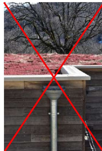
Les toitures-terrasses, bien qu'existantes très ponctuellement dans le village, ne sont pas à encourager car non traditionnelles dans la région.
