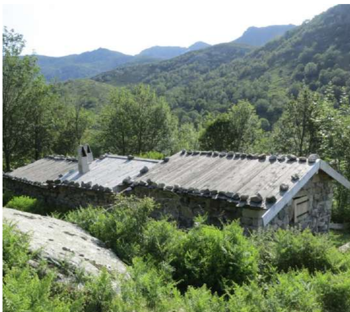
Couverture restaurée de la bergerie de Verdanes réalisée en planches de bois (châtaignier) stabilisées par de gros blocs en périphérie de couverture.
