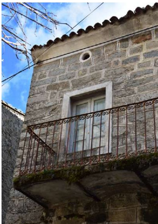
Les corniches visant à éloigner l'eau pluviale des murs, l'installation de gouttière n'est pas systématique. Plusieurs constructions du village n'en présentent pas.
