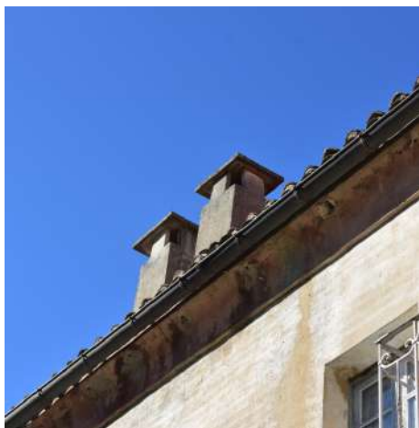
Conduits maçonnés en toiture avec couronnement plat. Enduit similaire à la façade.
