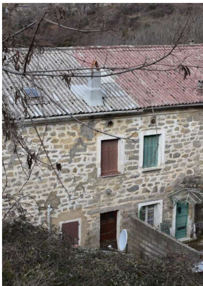
Les couleurs grises et ocre/terre-cuite se combinent en couverture à Bastelica.
