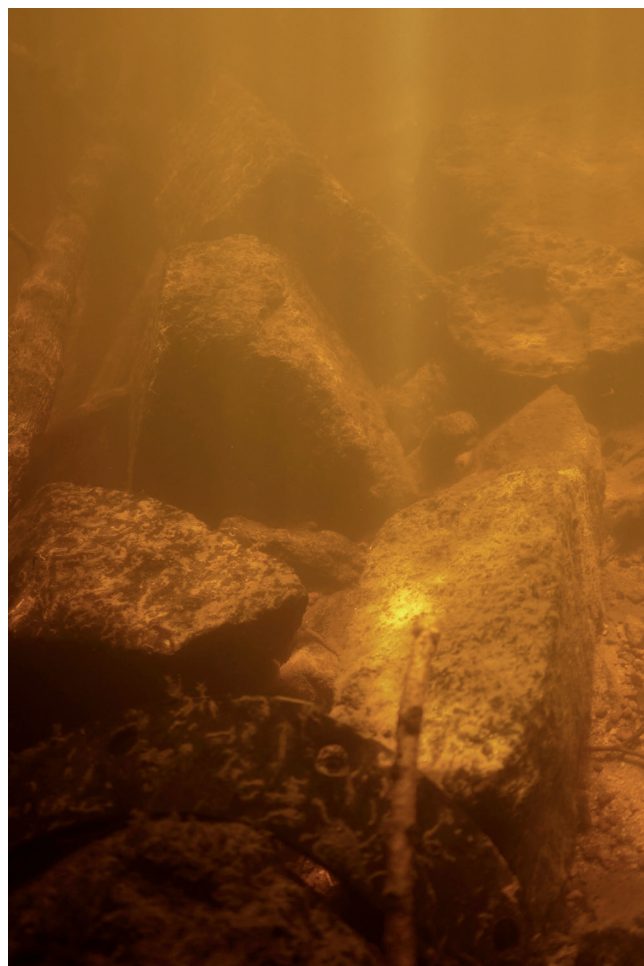
LIMOGES, Prospection dans la rivière Vienne et sondage subaquatique au pied du pont Saint-Martial - Blocs taillés au fond de la Vienne sous le pont Saint-Martial (cl. F. Loubignac)
