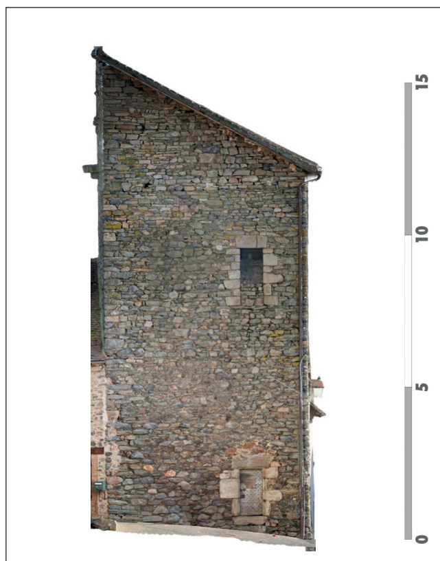
SAINT-GERMAIN-LES-BELLES, Tour de Saint-Germain - Façade nord-est de la tour, relevé lasergrammétrique (P. Jost, 2022)
