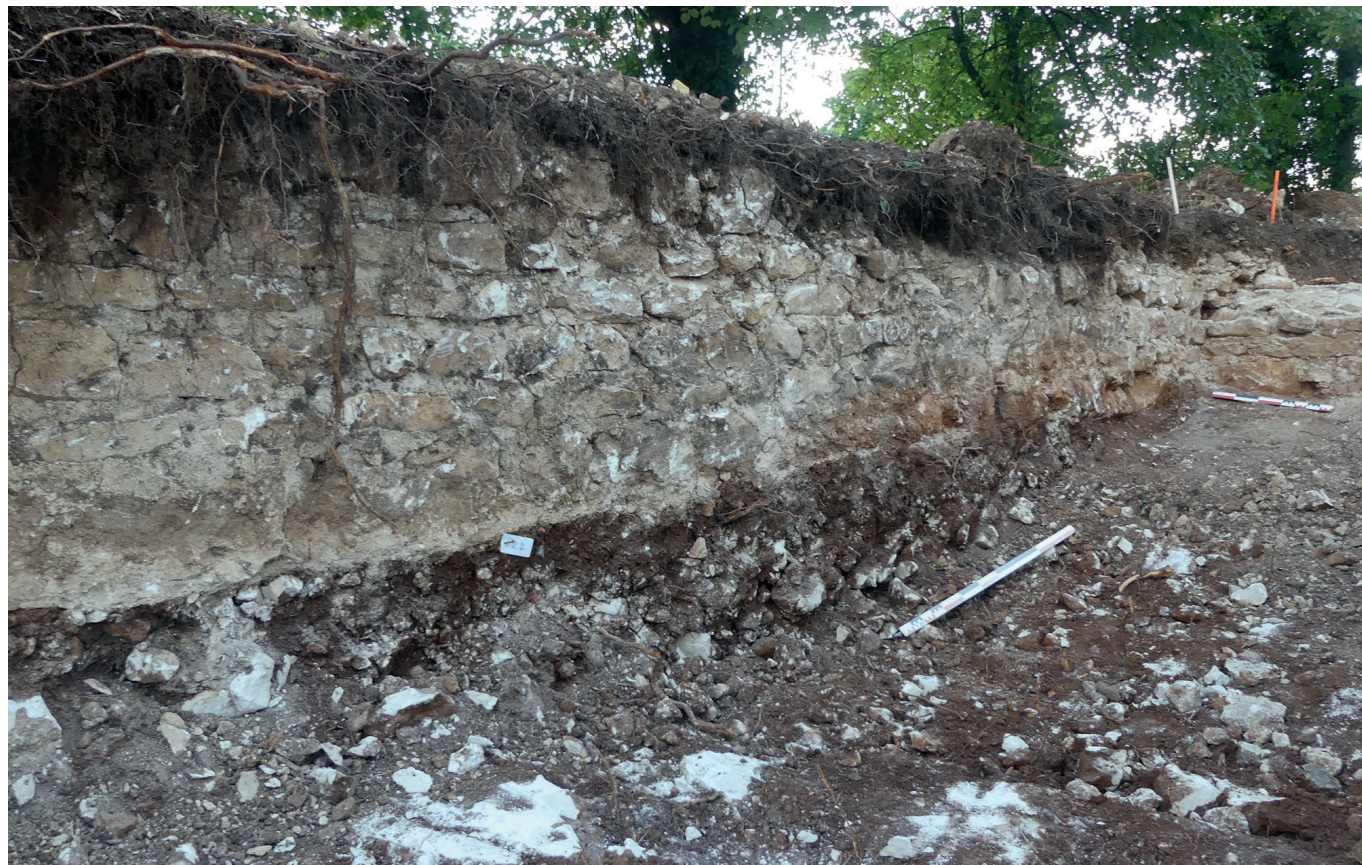
POITIERS, Le porteau, photographie des murs et fondations F. 2.2 et F. 2.3 (clichés : T. Pelmoine)
