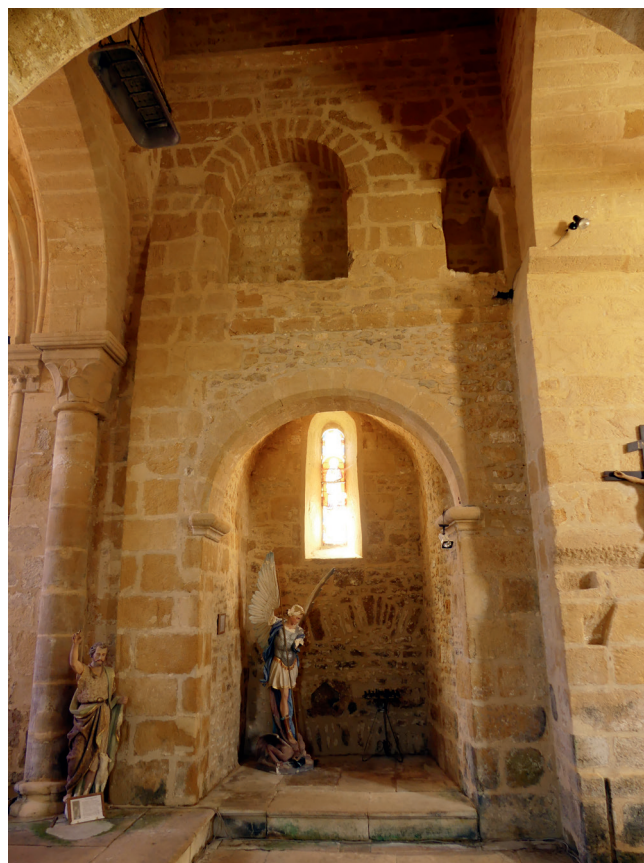
AURIAC-DU-PÉRIGORD, église Saint-Étienne-d'Auriac, Vue du mur sud de la travée sous clocher, cliché X. Lhermite© Éveha 2023.
